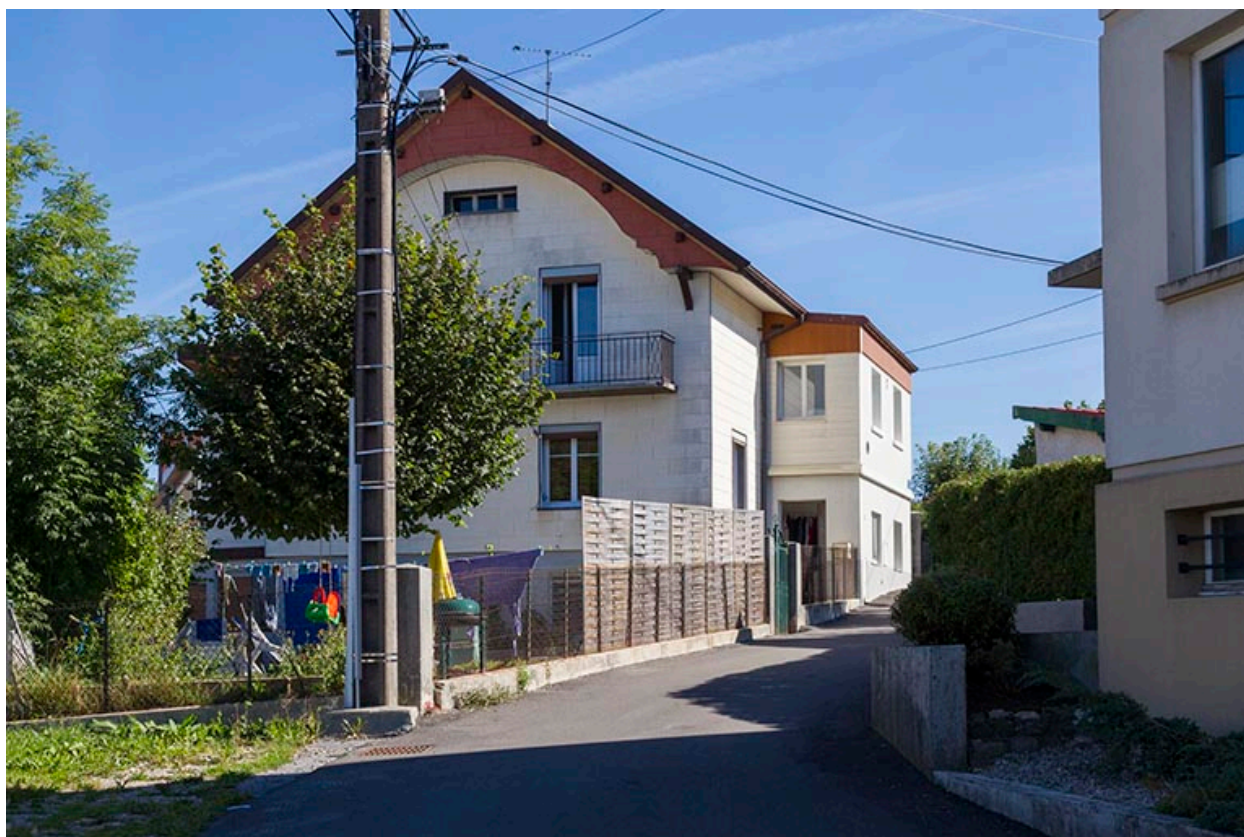
Maison : élévation ouest.
