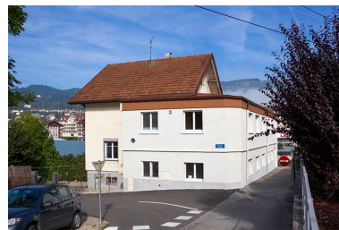
Atelier et maison : élévation sud. Phot. Yves Sancey IVR43_20132502025NUC2A
