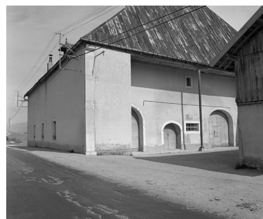
Façade sur rue, de trois quarts droit, et mur de croupe.
