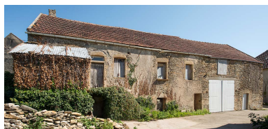
L'ensemble de la face principale, au sud-ouest. Phot. Nicolas Waltefaugle IVR26_20258900248NUC4A
