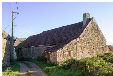
La ferme depuis la ruelle des grands prés, face nord-est. Phot. Nicolas Waltefaugle IVR26_20258900210NUC4A
