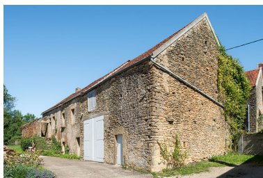
L'ensemble de la face principale, au sud-ouest. Phot. Nicolas Waltefaugle IVR26_20258900246NUC4A
