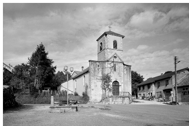
Extérieur : façade ouest et face sud. Phot. Yves Sancey IVR43_19943900946V
