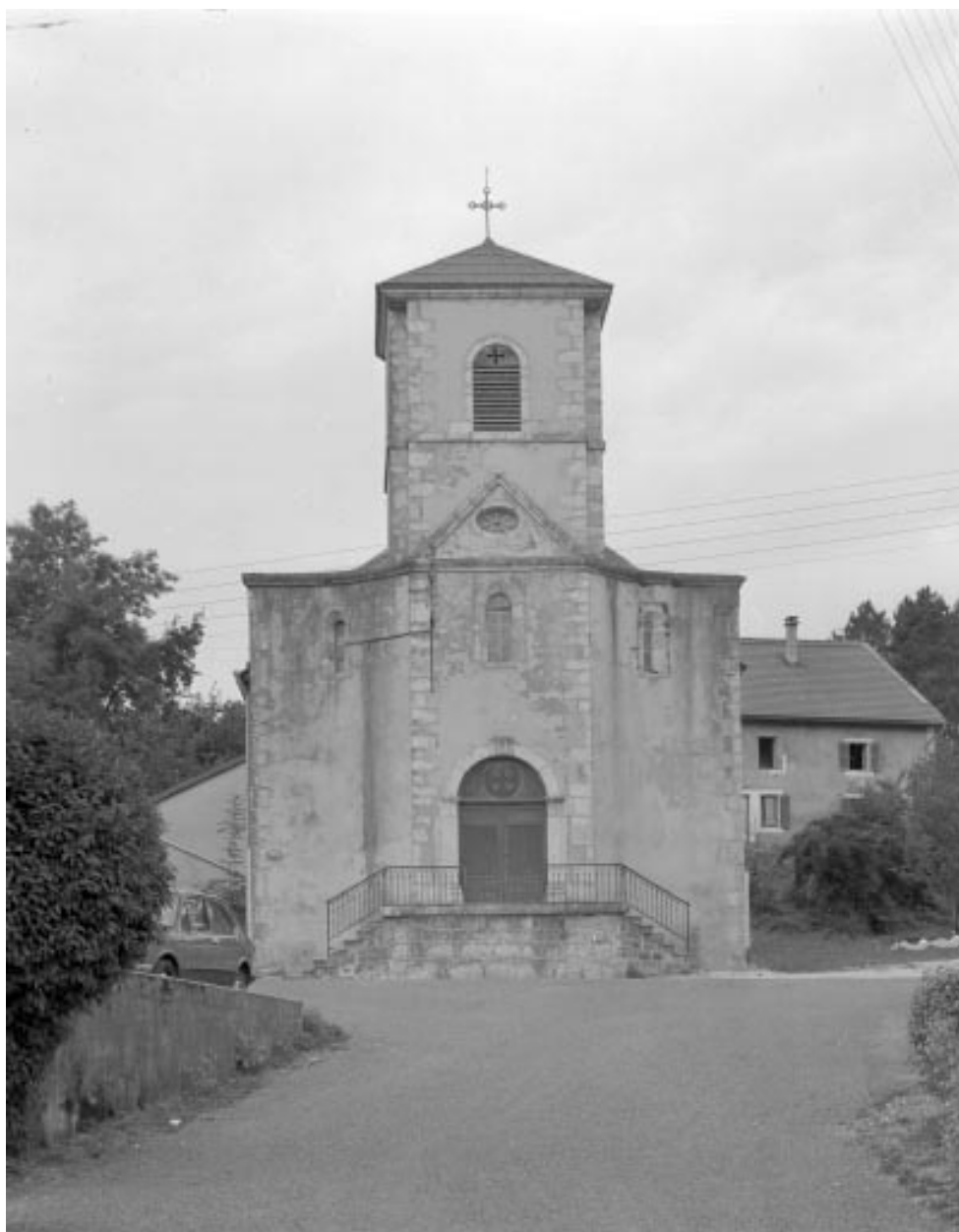
Extérieur : façade ouest.
