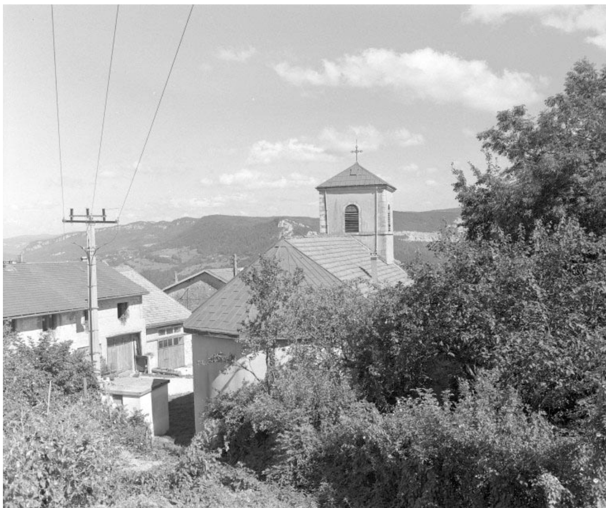
Extérieur : l'abside vue depuis le nord-est.
