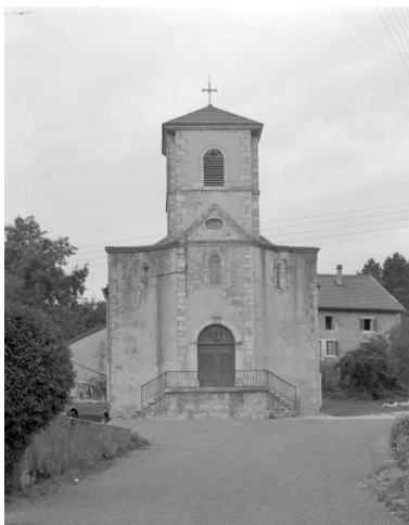
Extérieur : façade ouest. Phot. Yves Sancey IVR43_19943900947V
