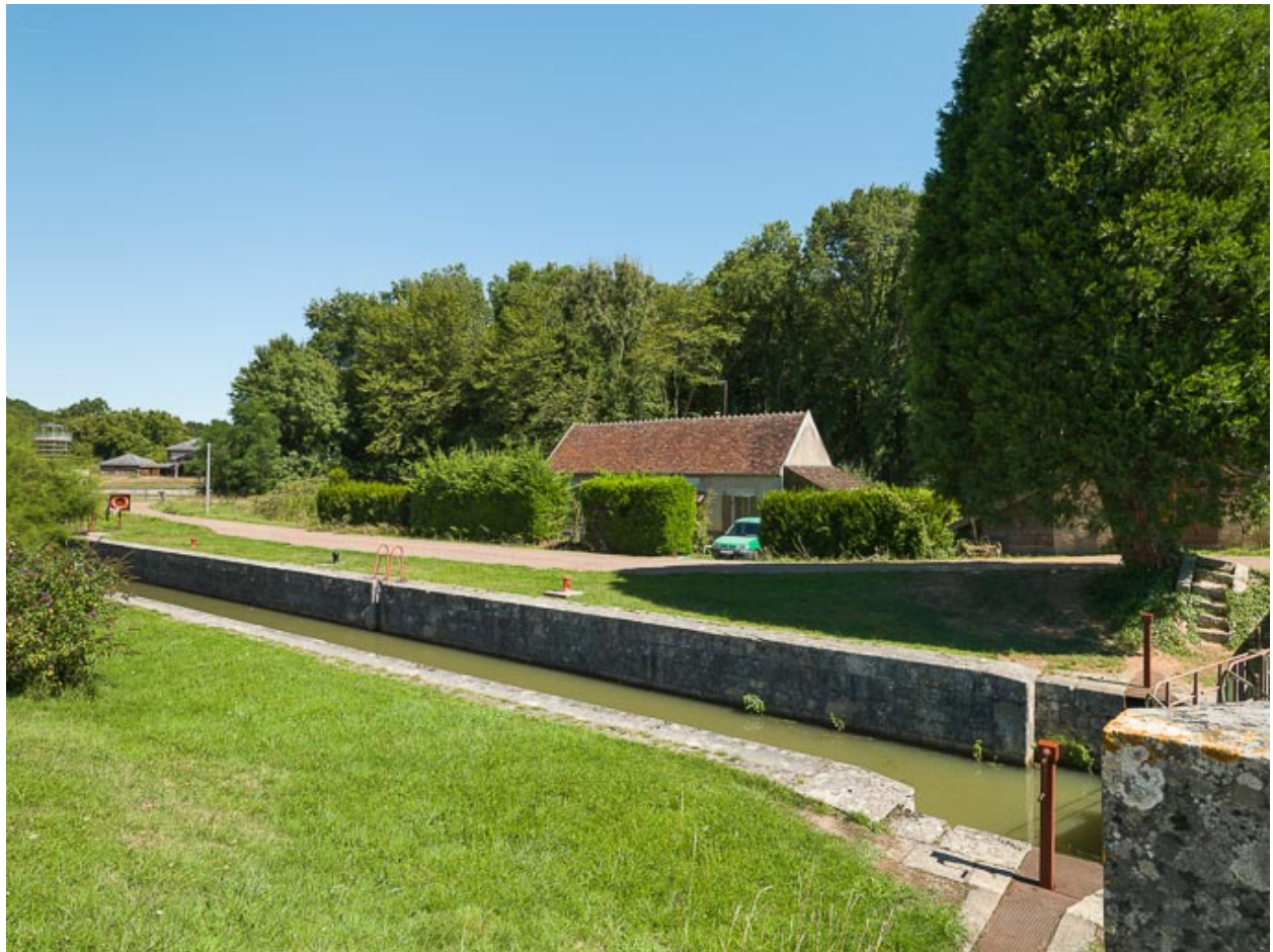
Vue du site d'écluse.
