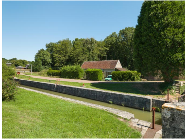
Vue du site d'écluse.
