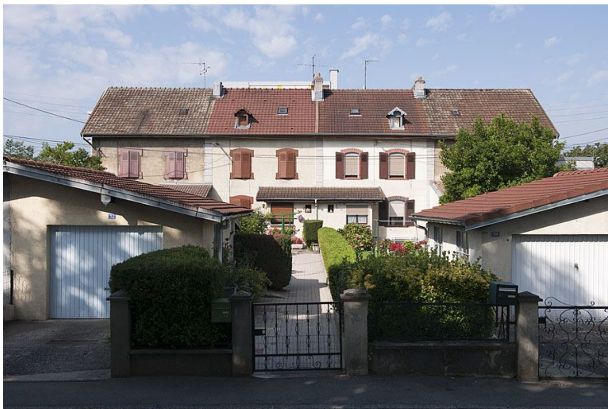
Façade ouest d'une habitation.
