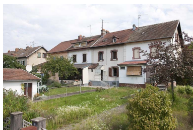
Habitation sud vue de trois quarts. Phot. Jérôme Mongreville IVR43_20112502034NUC4A
