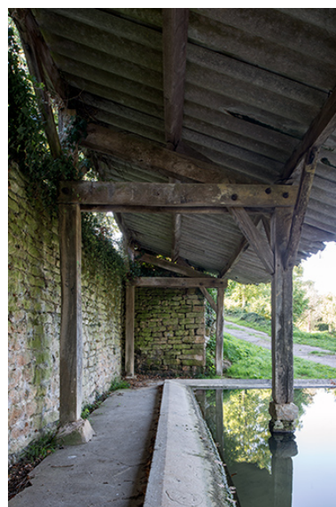
La structure de bois et le bord du bassin. Phot. Nicolas Waltefaugle IVR26_20258900219NUC4A
