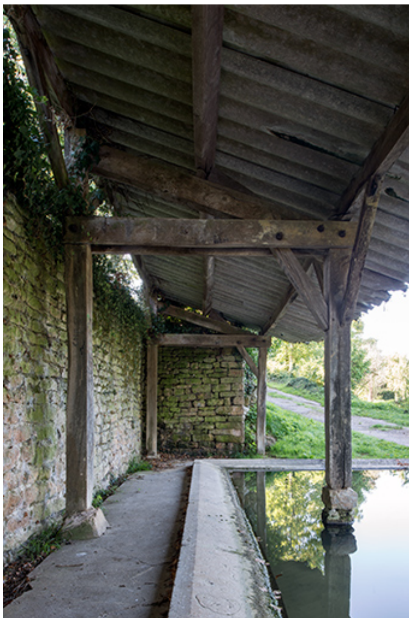
La structure de bois et le bord du bassin.
