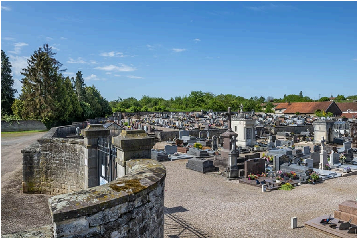
Détail du mur d'enceinte, du portail et vue du cimetière depuis l'est.
