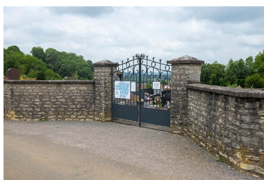
Entrée sud du cimetière, rue de la Pietà. Phot. Jérôme Mongreville IVR43_20217000301NUC4A
