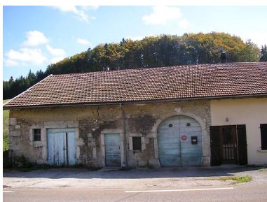
Vue générale de la façade antérieure.
