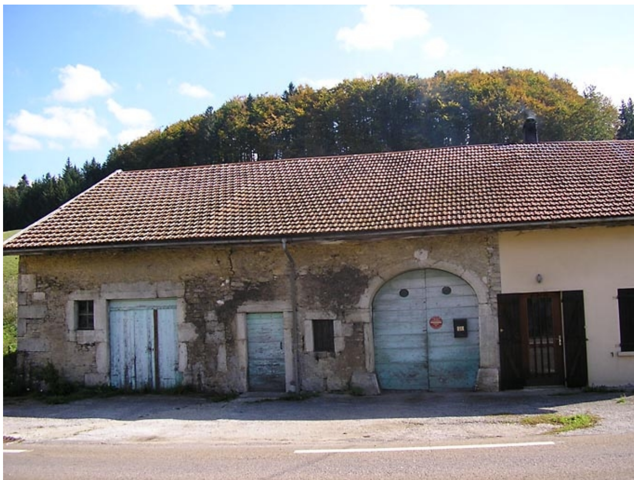
Vue générale de la façade antérieure.
