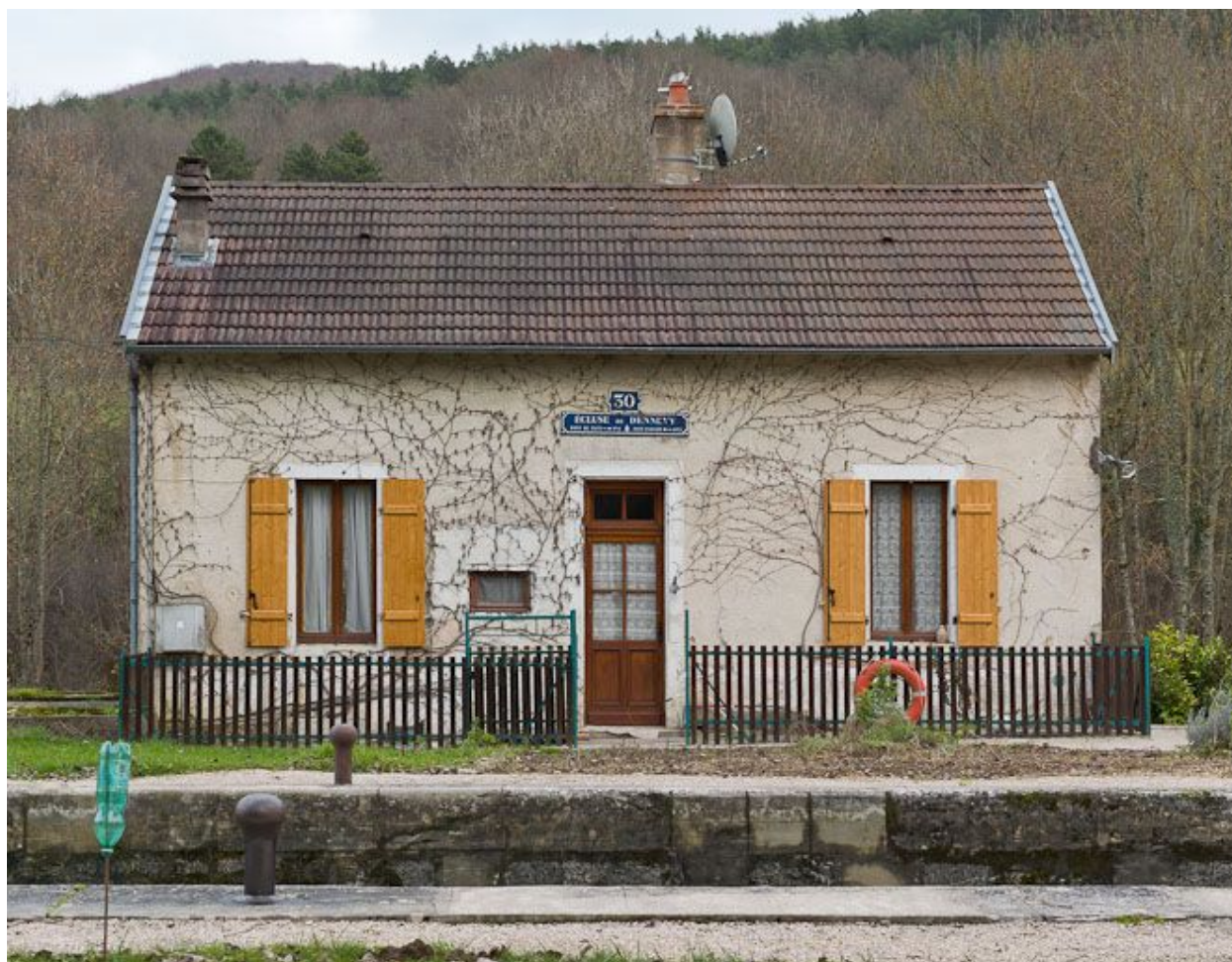
Vue de face de la maison éclusière.
