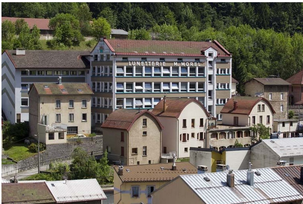
Vue d'ensemble de la façade postérieure.
