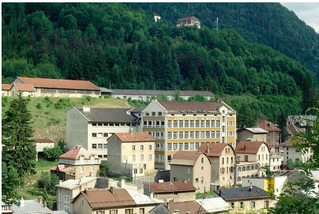
Vue d'ensemble de la façade postérieure.
