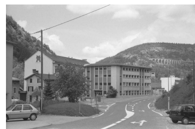
Façade antérieure du bâtiment de 1977. Phot. Laurent Poupard IVR43_19913901455Z
