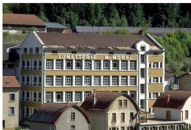
Façade postérieure de l'atelier de 1936. Phot. Laurent Poupard IVR43_19913901456ZA
