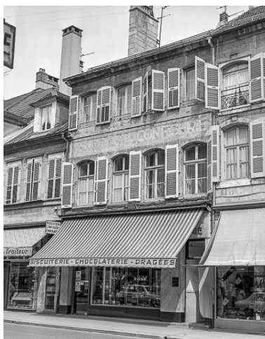
Maison située 30 rue de la République. Phot. Yves Sancey IVR43_19802500218X
