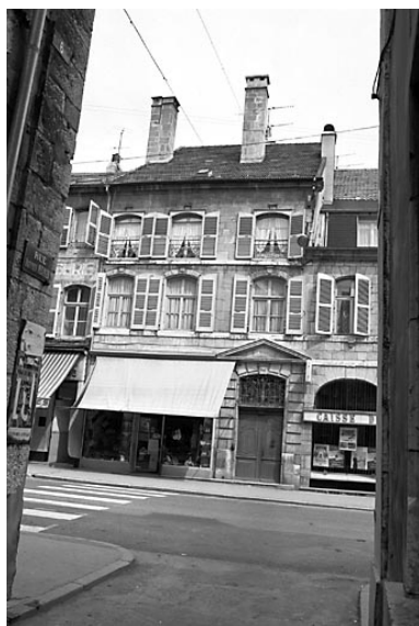
Maison située 28 rue de la République. Phot. Yves Sancey IVR43_19802500216X
