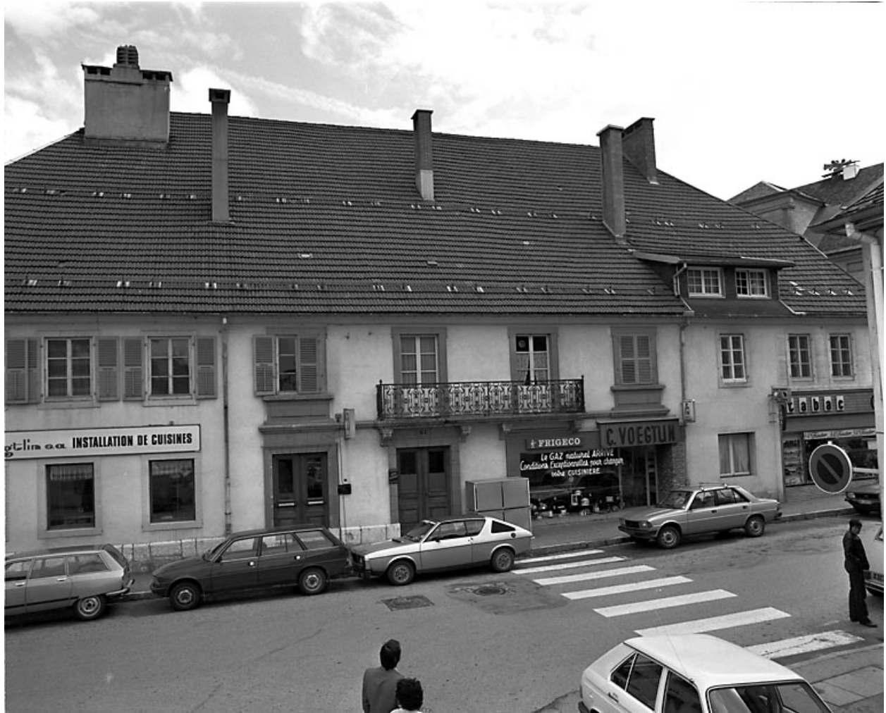
Maison située 9 rue de la Halle.
