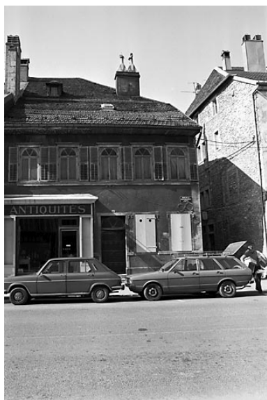
Maison située 79 rue de la République. Phot. Yves Sancey IVR43_19802500225X
