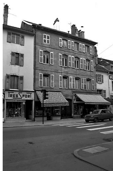
Maison située 72 rue de la République. Phot. Yves Sancey IVR43_19802500224X
