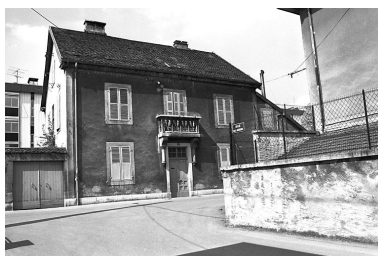
Maison située 7 rue des Remparts. Phot. Yves Sancey IVR43_19802500243X
