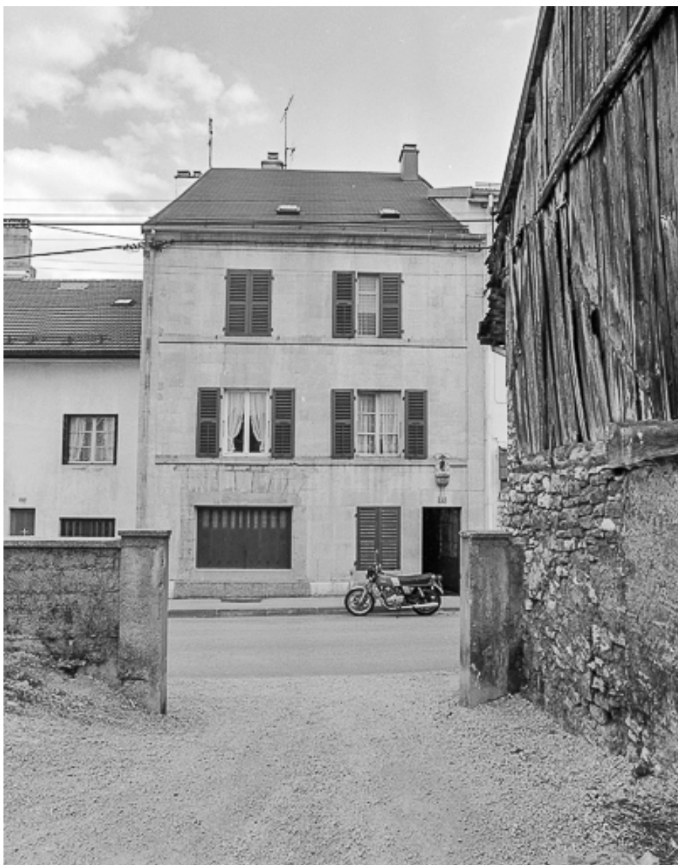
Maison située 25 rue Montrieux.
