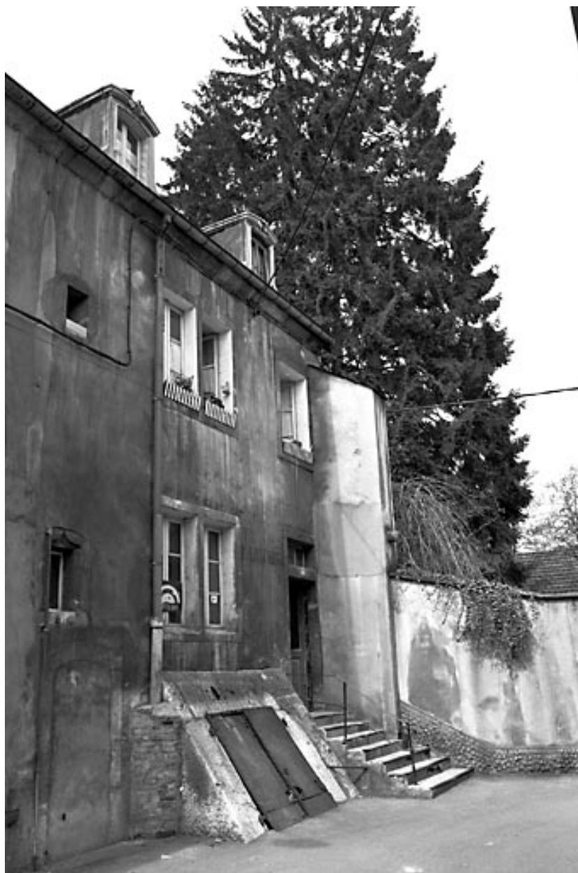
Maison située 10-12 rue Parguez.
