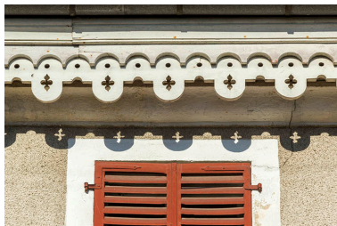
Détail du lambrequin. Phot. Sonia Dourlot IVR43_20157001397NUC2A
