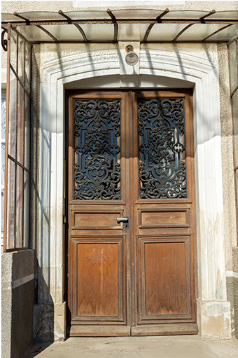
Détail de la porte principale sur rue.
