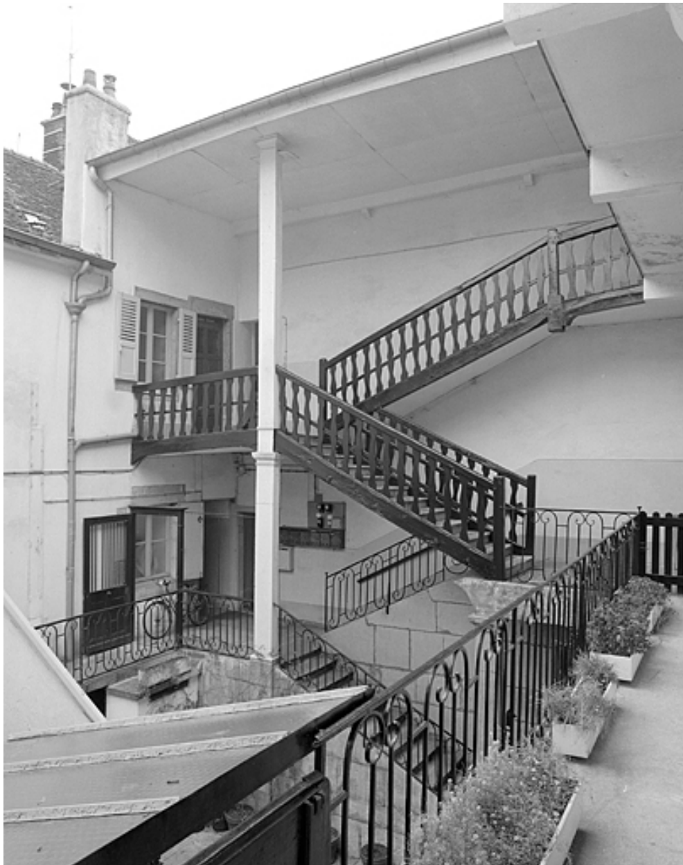
Escalier dans la cour.
