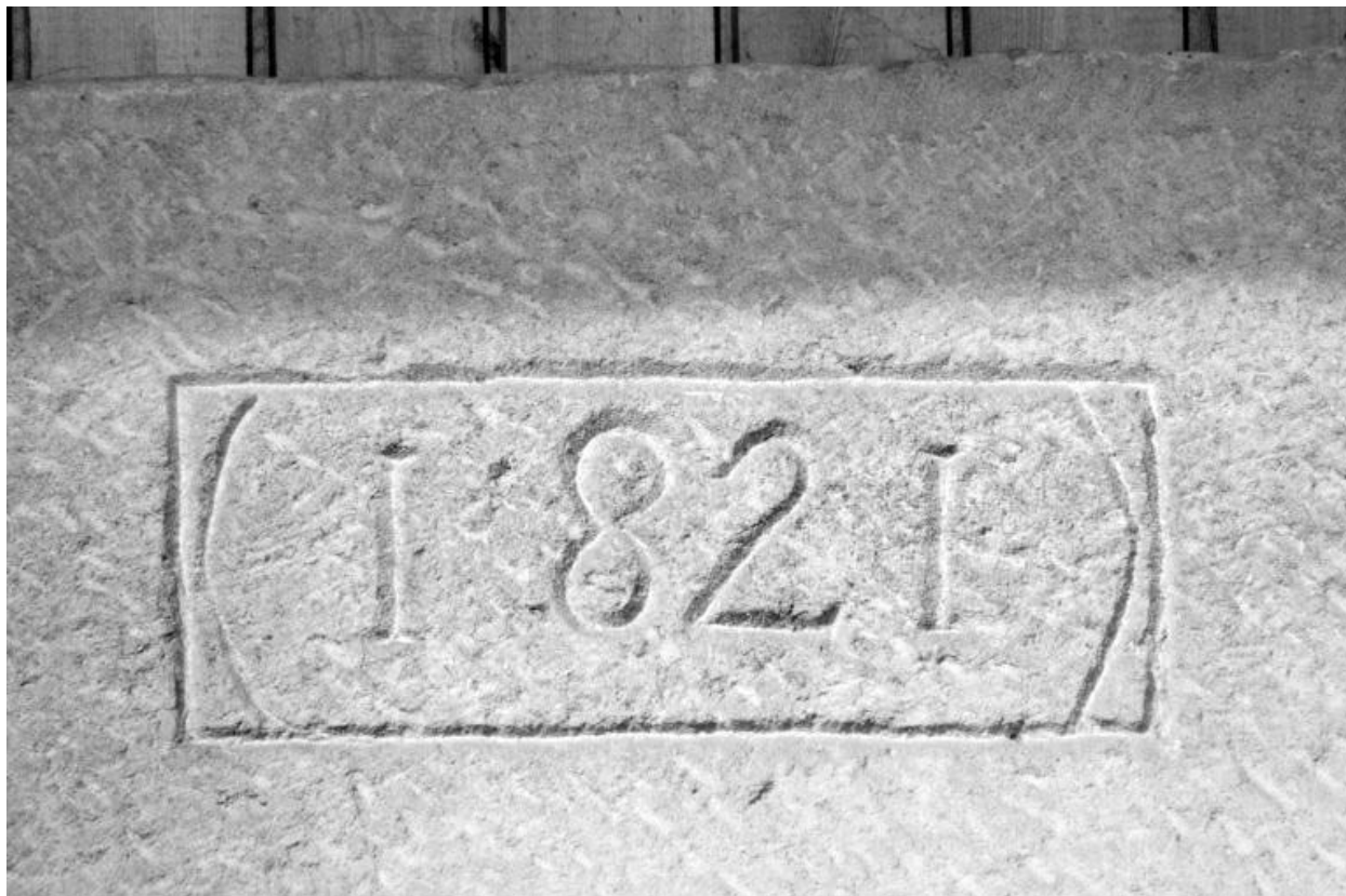
Moulin, porte d'entrée orientale : date portée.
