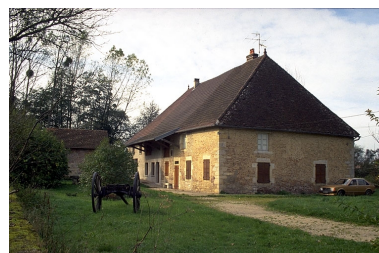
Moulin et four à pain. Phot. Laurent Poupard IVR43_19883900672ZA
