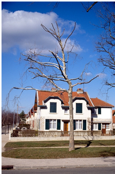
Face latérale droite vue de face. Phot. Laurent Poupard IVR43_19893900553ZA
