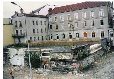
[Photographie montrant le bâtiment du pensionnat Jolyet situé rue de Belfort avec le bastion Royal mis à jour mais pas encore restauré]. 1995. (2Fi8).
