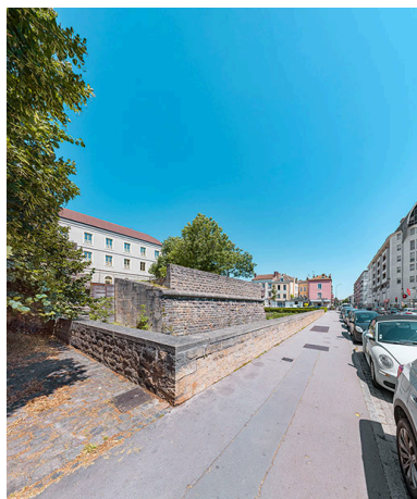
Le bastion, vu depuis la rue de Belfort.
