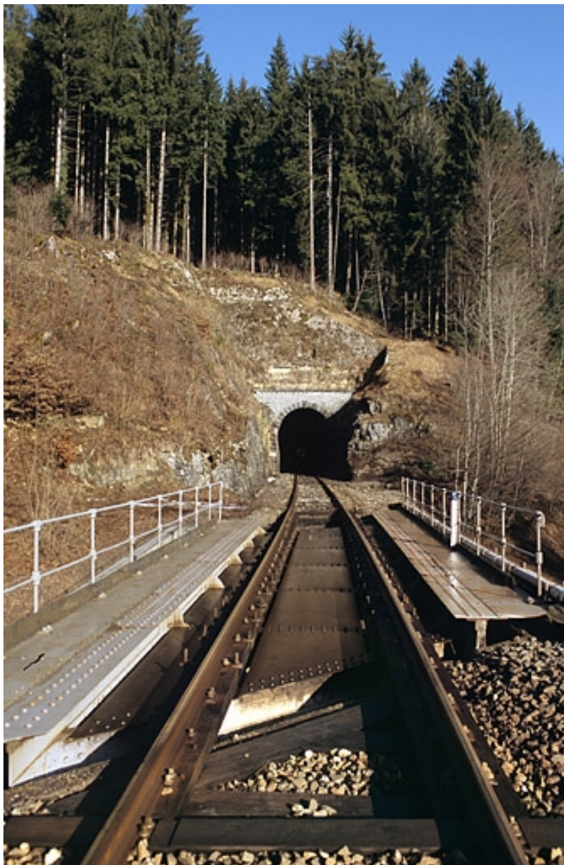
Pont sur la route nationale n° 5 : tablier, depuis la voie côté La Cluse.
