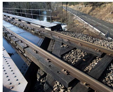
Pont sur la Lemme : jonction du tablier et de la culée droite, depuis la voie.
