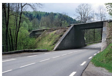
Pont sur la route nationale n ° 5 : vue d'ensemble, depuis le côté Andelot-en-Montagne Phot. Yves Sancey IVR43_20053900187ZA
