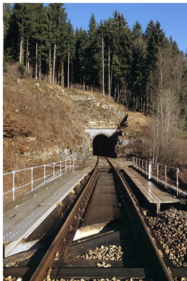
Pont sur la route nationale n° 5 : tablier, depuis la voie côté La Cluse.
