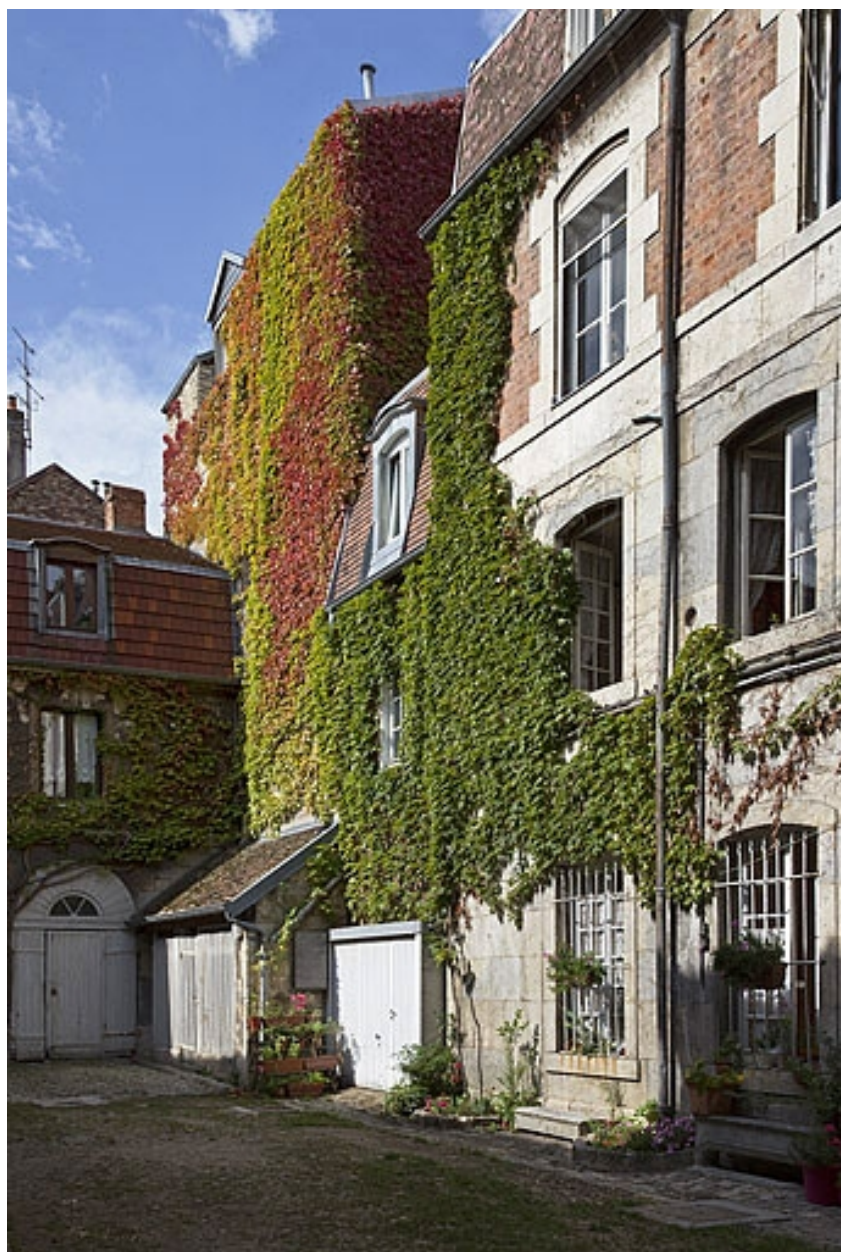
Vue d'ensemble du premier logis secondaire, de trois quarts droit.
