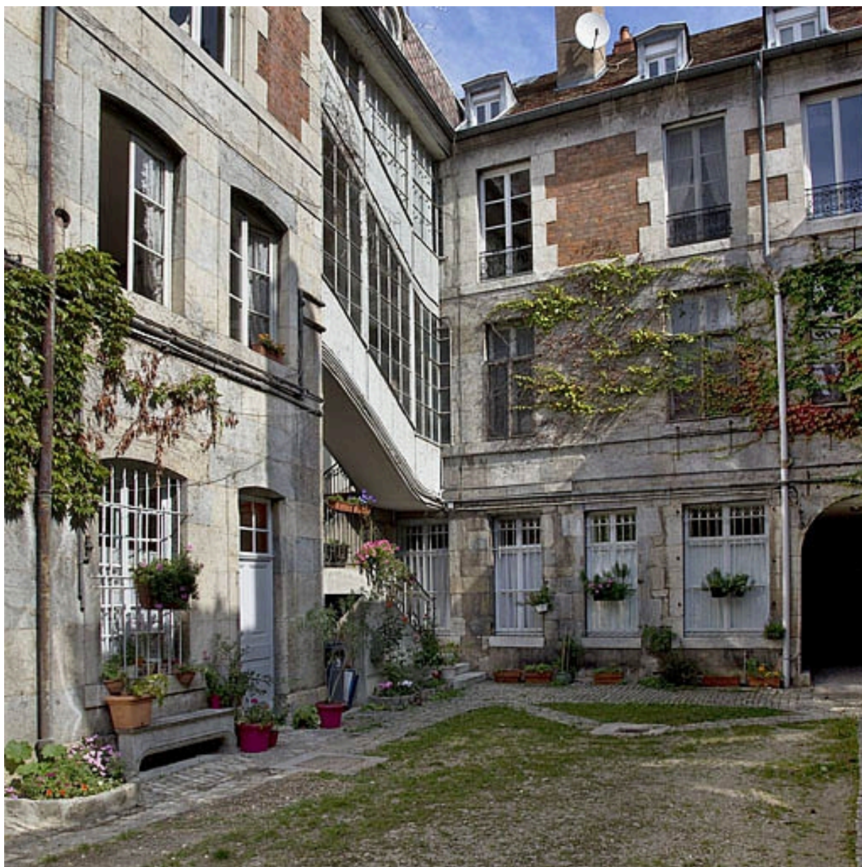
Façade postérieure du logis principal et escalier à cage ouverte, de trois quarts gauche.
