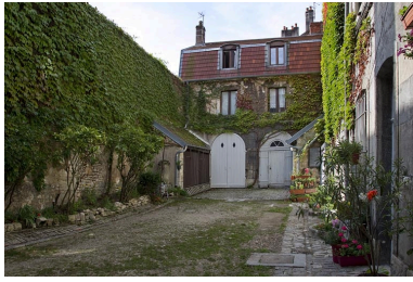
Deuxième logis secondaire : vue d'ensemble depuis l'entrée de la cour. Phot. Yves Sancey IVR43_20112502851NUC2A
