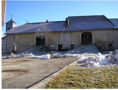
Façade postérieure. Phot. Marie-Pierre Reynet IVR43_20083900466NUC1A
