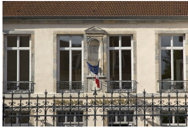
Façade antérieure : détail de la niche. Phot. Yves Sancey IVR43_20112501754NUC2A
