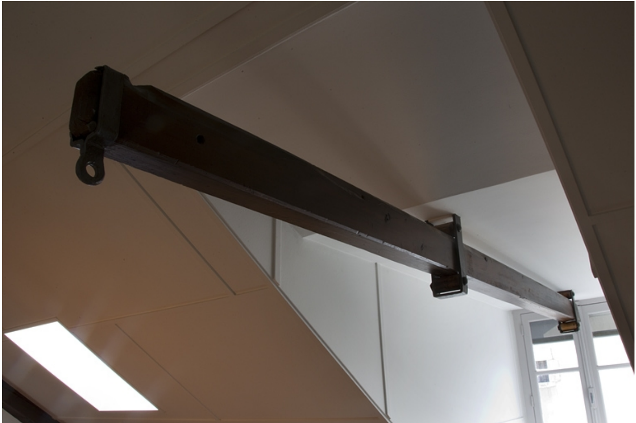
Aile droite, intérieur : détail d'un monte-charge.
