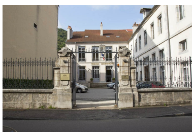
Vue d'ensemble, de face, depuis la rue.
