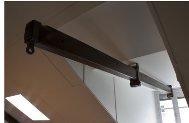
Aile droite, intérieur : détail d'un monte-charge. Phot. Yves Sancey IVR43_20112501758NUC2A
