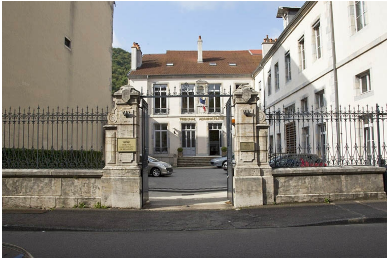
Vue d'ensemble, de face, depuis la rue.
