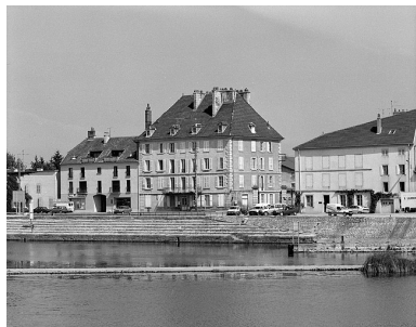
Vue d'ensemble depuis le pont. Phot. Yves Sancey IVR43_19917000267X
