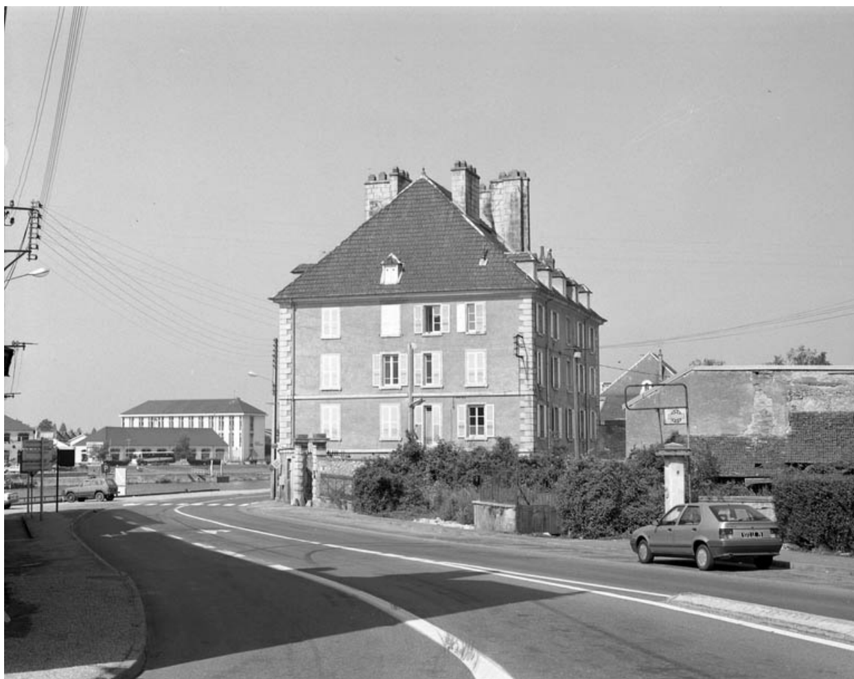
Vue de la façade latérale droite.
