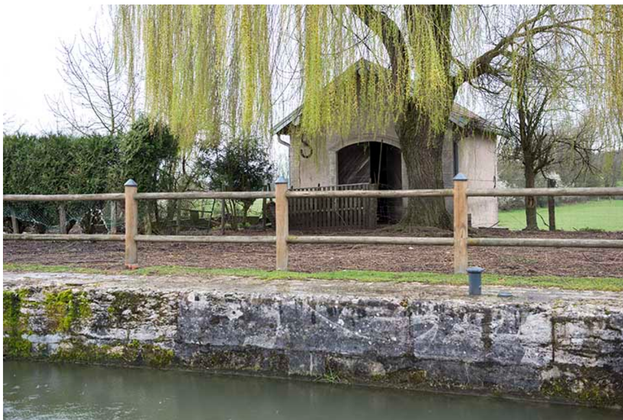
La remise portant la date de 1878.
