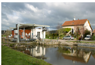
Vue générale de l'ouvrage. Phot. Sonia Dourlot IVR43_20157000145NUC2A
