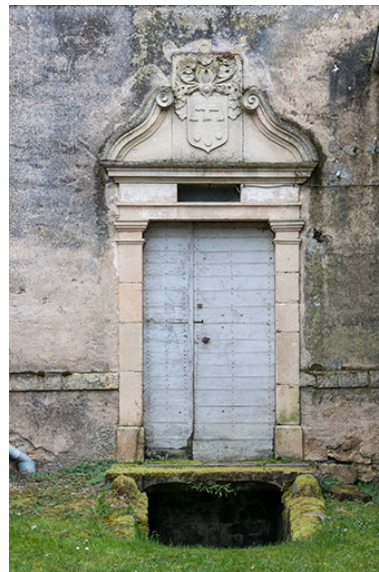
La porte d'entrée. Phot. Jérôme Mongreville IVR43_20167000205NUC4A
