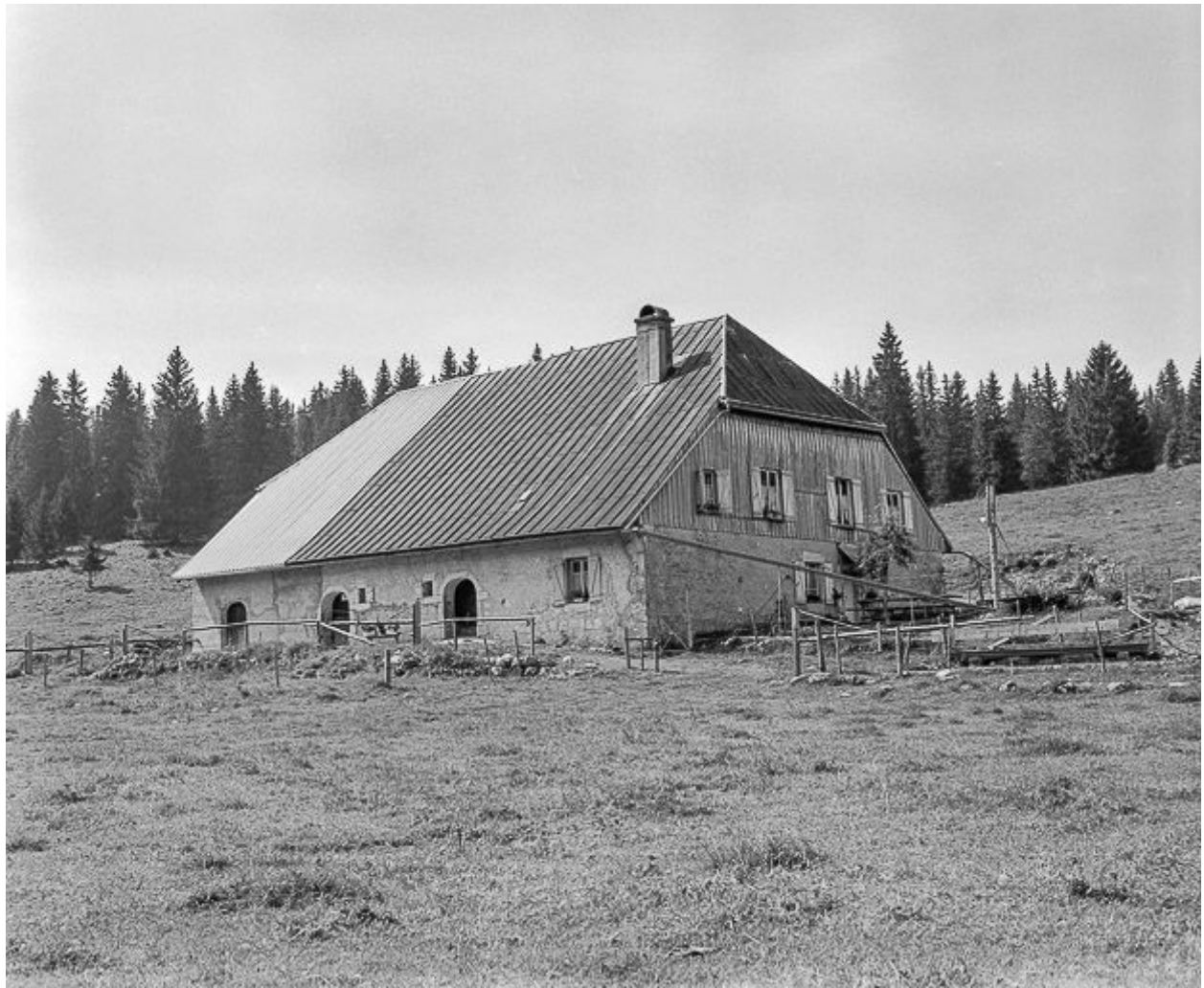
Façade antérieure et latérale gauche.
