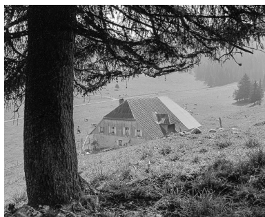
Pignon antérieur et goutterot droit. Phot. Yves Sancey IVR43_19782500387X
