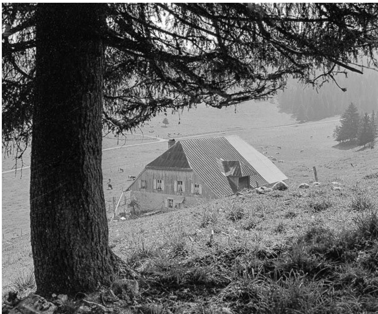
Pignon antérieur et goutterot droit.
