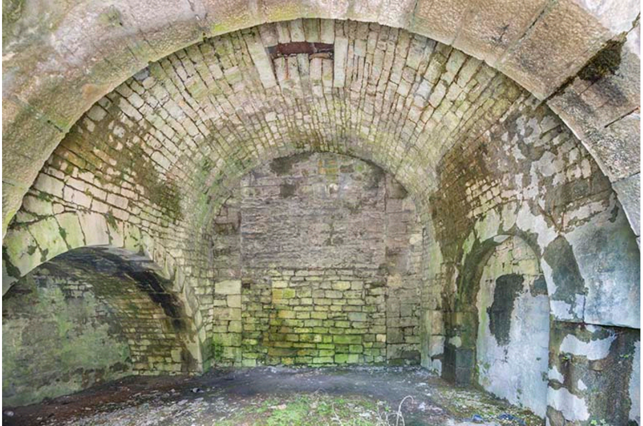
Pièce voûtée en berceau, située au nord de la tour est (vestiges du bâtiment construit en 1661 ?).
