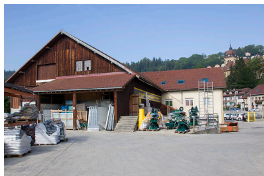
Bâtiments, vus de l'est.
