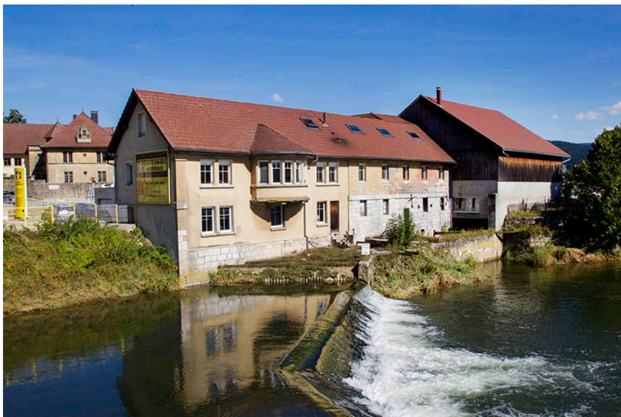
Façades postérieure et latérale droite.
