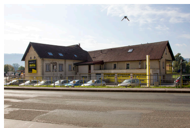
Façades antérieure et latérale droite.
