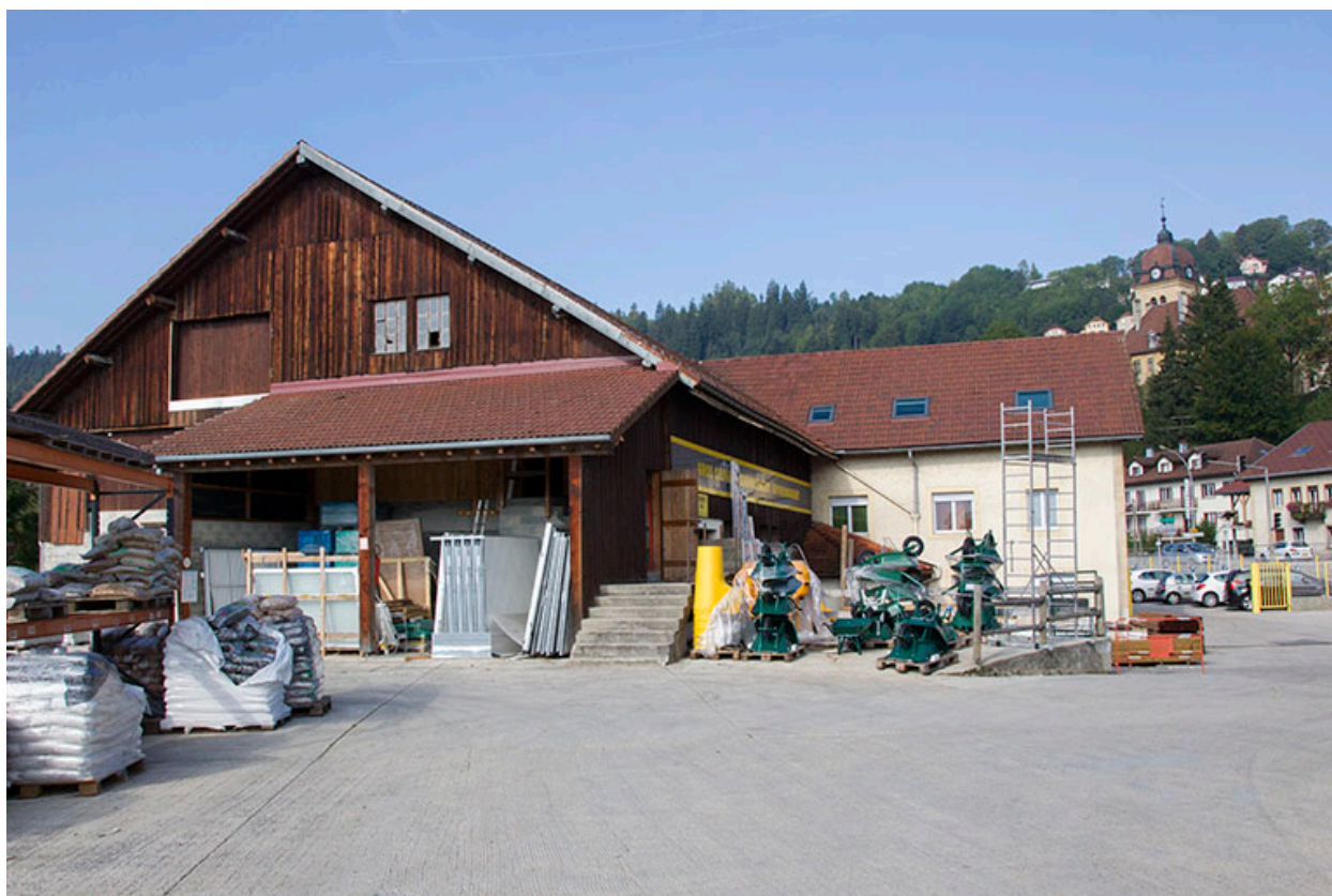
Bâtiments, vus de l'est.
