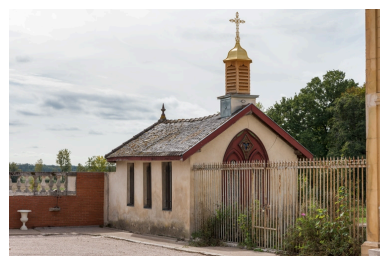
Chapelle, depuis la cour. Phot. Pierre-Marie Barbe-Richaud IVR26_20222100913NUC4A
