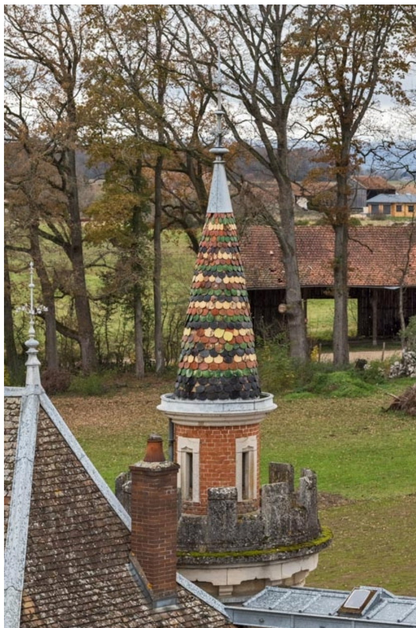
Galerie : tourelle ouest, depuis le "Donjon".
