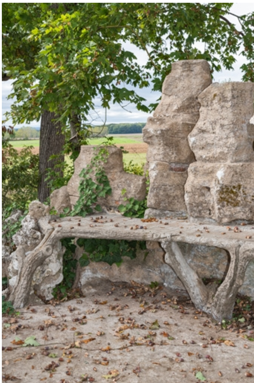
Grotte : banc en béton sur la terrasse.
