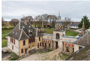
Demeure et galerie : vue plongeante depuis le "Donjon". Phot. Pierre-Marie Barbe-Richaud IVR26_20212100482NUC4A
