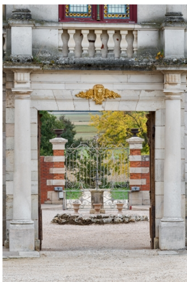
Galerie : porte cochère, vantaux ouverts. Phot. Pierre-Marie Barbe-Richaud IVR26_20222100863NUC4A
