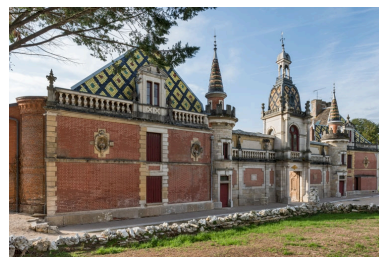
Élévation antérieure, de trois quarts gauche. Phot. Pierre-Marie Barbe-Richaud IVR26_20222100877NUC4A
