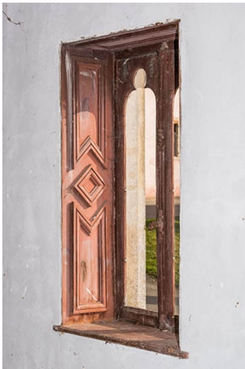
"Château neuf" : boiserie d'ébrasement de fenêtre dans l' "appartement des bains".
