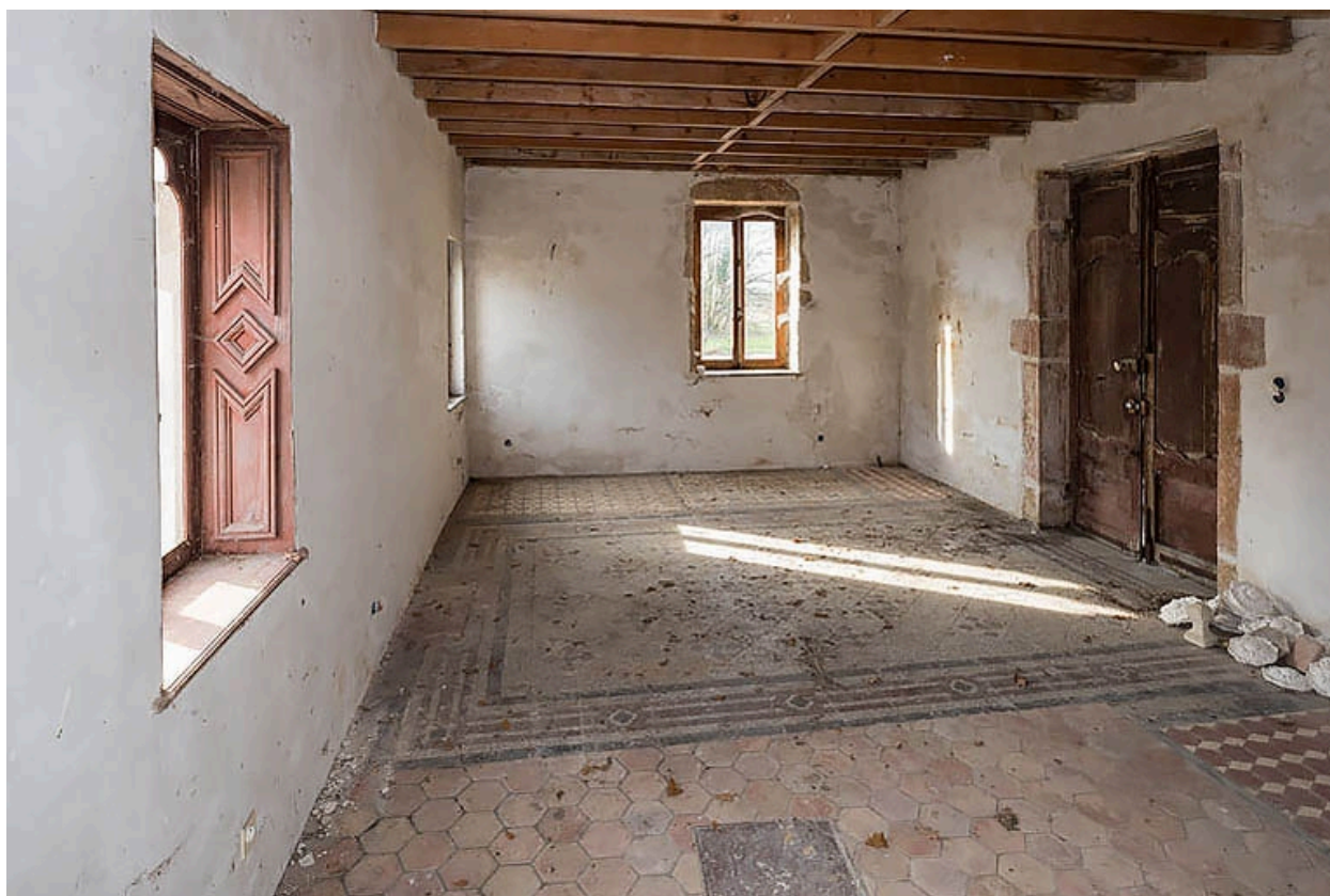
"Château neuf" : intérieur au rez-de-chaussée de l' "appartement des bains".
