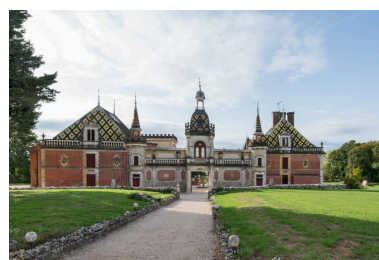
Elévation antérieure (nord). Phot. Pierre-Marie Barbe-Richaud IVR26_20222100878NUC4A
