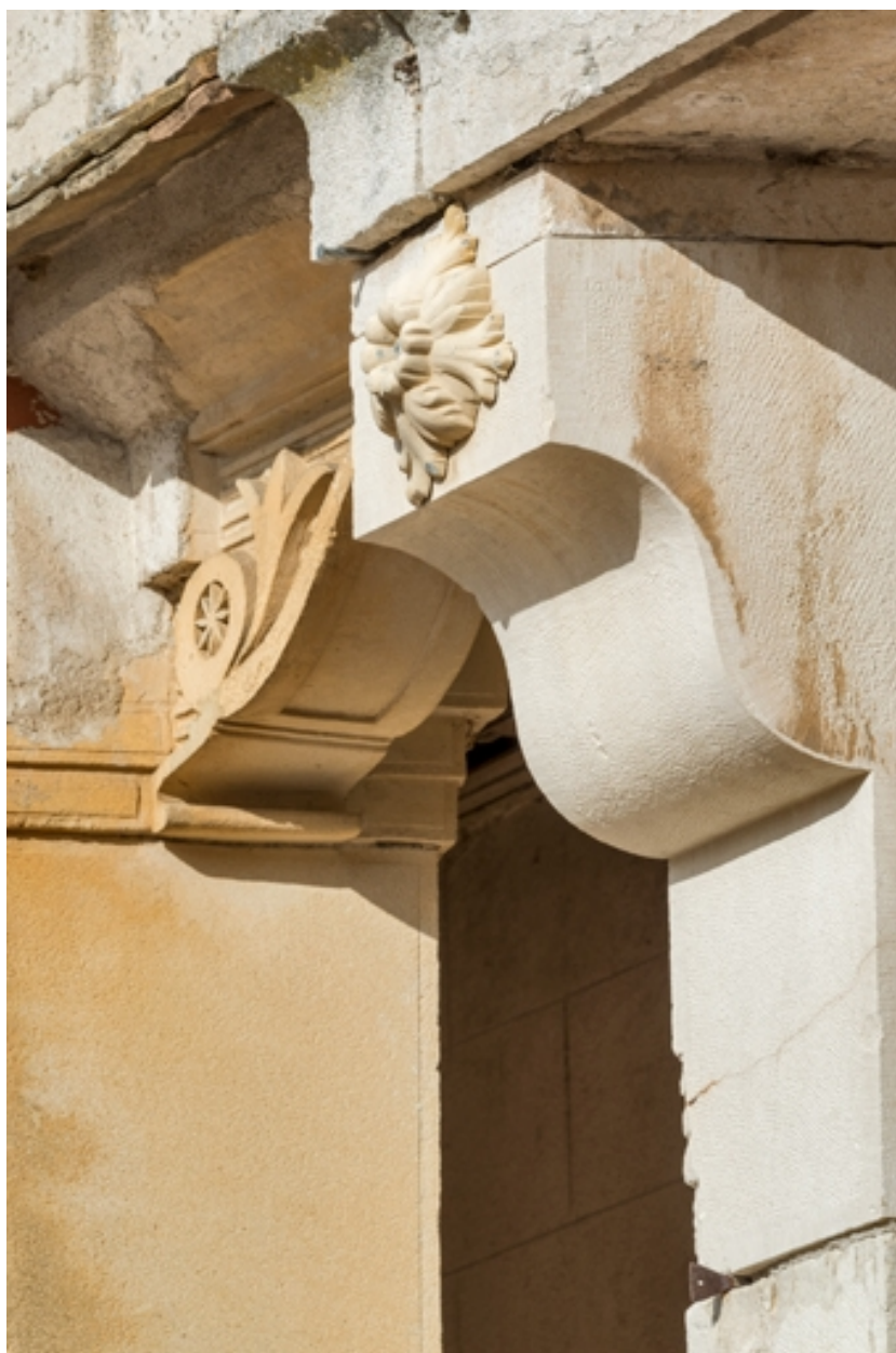
Galerie : supports côté cour (corbeaux).
