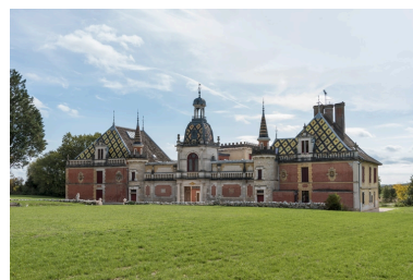
Vue d'ensemble, depuis le nord-ouest. Phot. Pierre-Marie Barbe-Richaud IVR26_20222100905NUC4A
