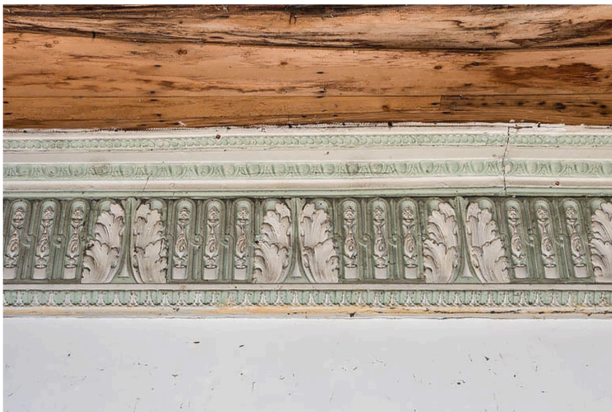
"Château neuf" : moulure dans la chambre à l'étage de la "Tour du Four".
