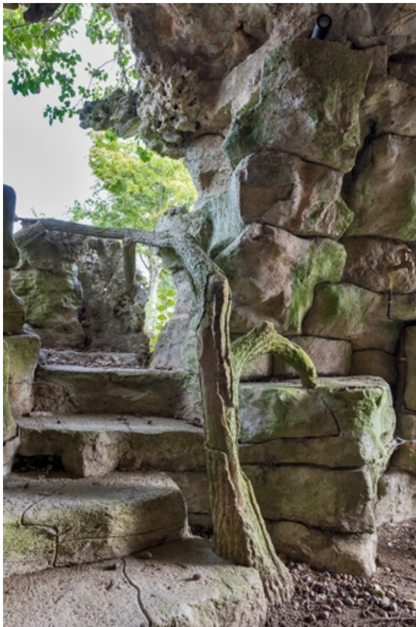
Grotte : départ de la rampe d'escalier.
