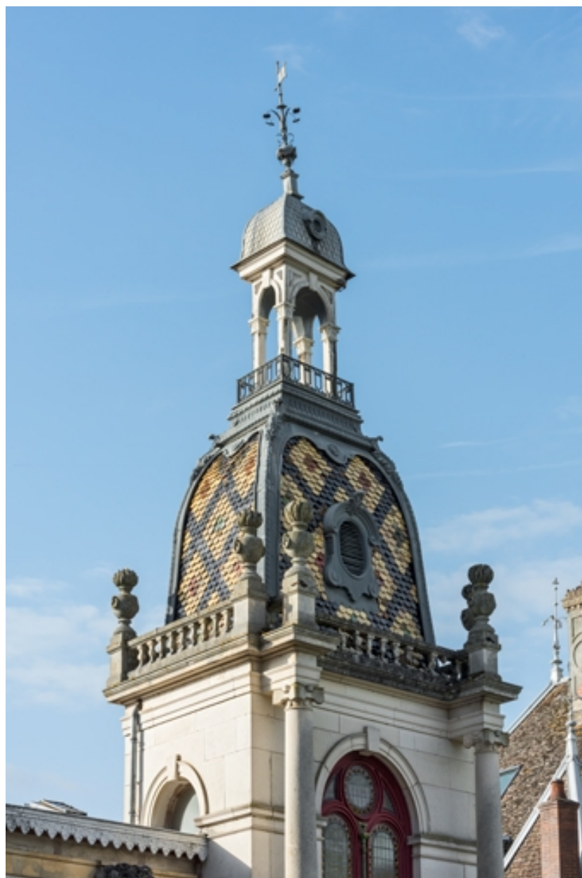
Galerie : dôme et lanterneau du pavillon d'entrée, vus de trois quarts.
