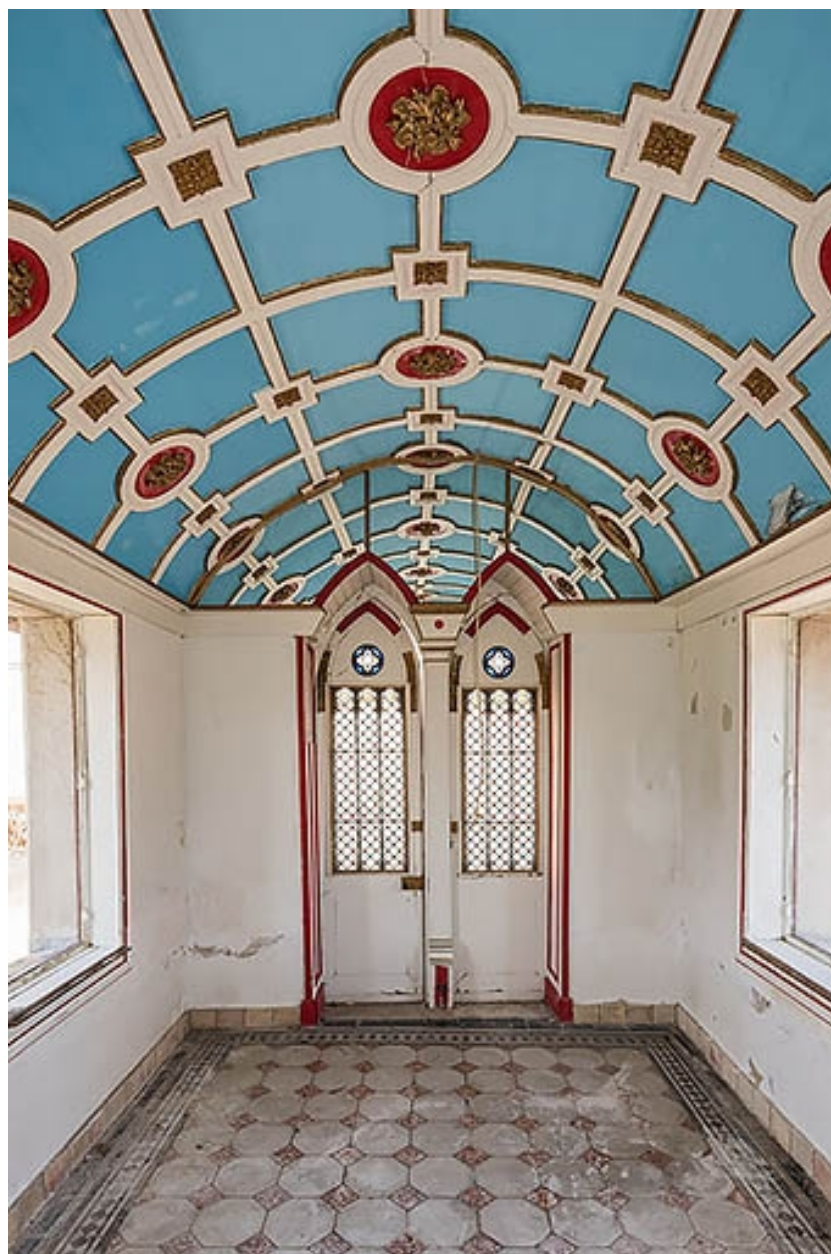
Chapelle : vue intérieure vers l'entrée.
