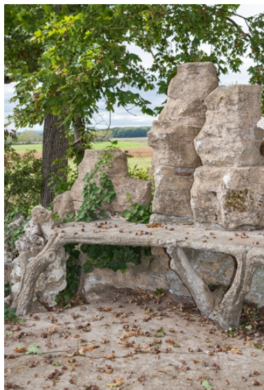
Grotte : banc en béton sur la terrasse. Phot. Pierre-Marie Barbe-Richaud IVR26_20222100938NUC4A
