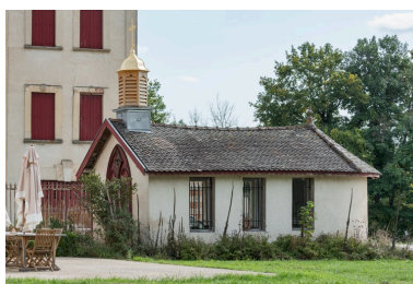
Chapelle : élévation latérale droite (ouest). Phot. Pierre-Marie Barbe-Richaud IVR26_20222100901NUC4A
