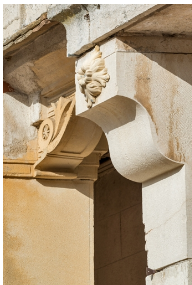
Galerie : supports côté cour (corbeaux). Phot. Pierre-Marie Barbe-Richaud IVR26_20222100889NUC4A
