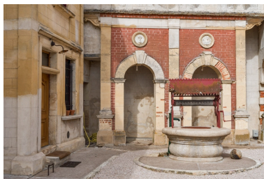
Angle nord-ouest de la cour, avec le puits. Phot. Pierre-Marie Barbe-Richaud IVR26_20222100915NUC4A
