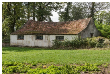
Etable : vue d'ensemble, depuis le nord-est. Phot. Pierre-Marie Barbe-Richaud IVR26_20222100920NUC4A
