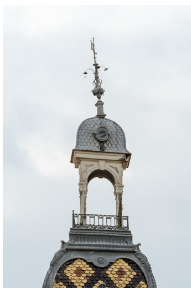
Galerie : lanterneau sur le pavillon d'entrée. Phot. Pierre-Marie Barbe-Richaud IVR26_20222100865NUC4A
