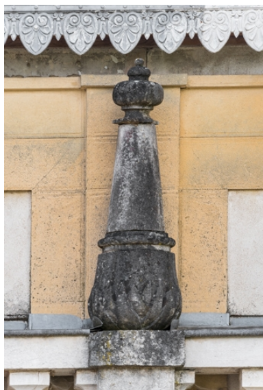
Galerie : motif d'amortissement. Phot. Pierre-Marie Barbe-Richaud IVR26_20222100870NUC4A
