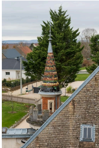
Galerie : tourelle est, depuis le "Donjon". Phot. Pierre-Marie Barbe-Richaud IVR26_20212100487NUC2A
