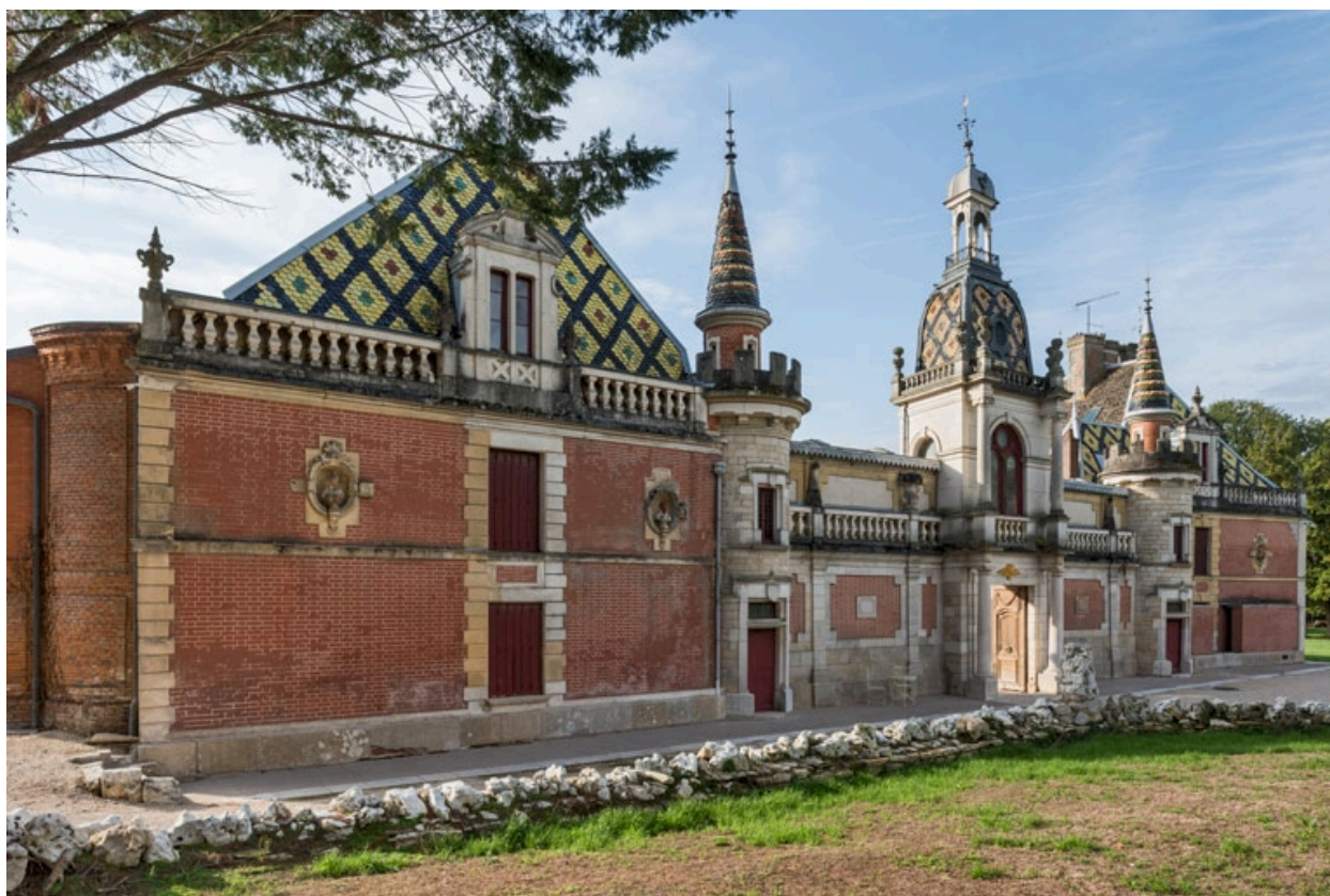
Elévation antérieure, de trois quarts gauche.
