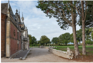
Chemin et muret en avant de l'élévation antérieure. Phot. Pierre-Marie Barbe-Richaud IVR26_20222100879NUC4A
