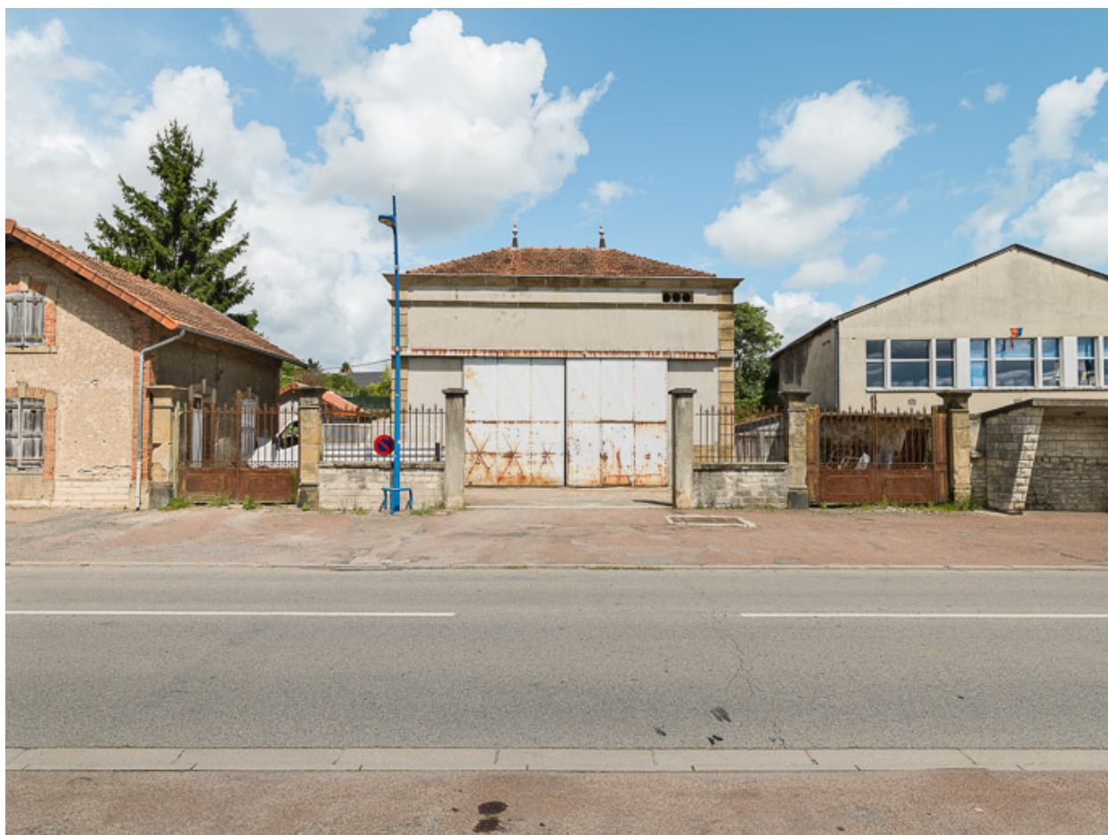
VUe générale de la station.
