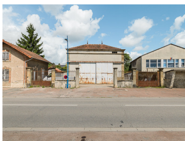
VUE générale de la station.
