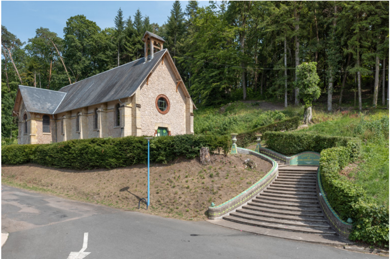
Flanc gauche et façade.
