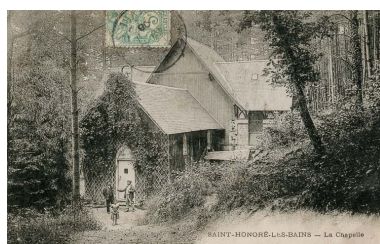
Vue extérieure au début des années 1900. Phot. auteur inconnu IVR26_20195800155NUC2A
