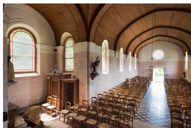
Nef et bras droit du transept, vue depuis le chœur. Phot. Pierre-Marie Barbe-Richaud IVR26_20195800289NUC4A
