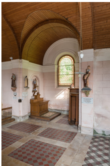
Bras droit du transept, vue depuis la nef. Phot. Pierre-Marie Barbe-Richaud IVR26_20195800374NUC4A
