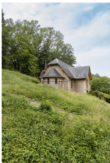
Situation de la chapelle sur la colline des Garennes. Phot. Pierre-Marie Barbe-Richaud IVR26_20195800283NUC4A
