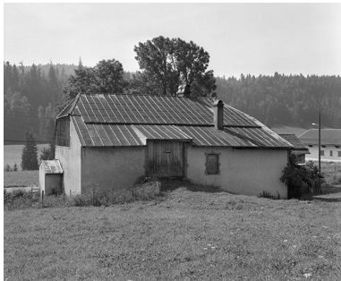
Façade postérieure. Phot. Yves Sancey IVR43_19782500471X
