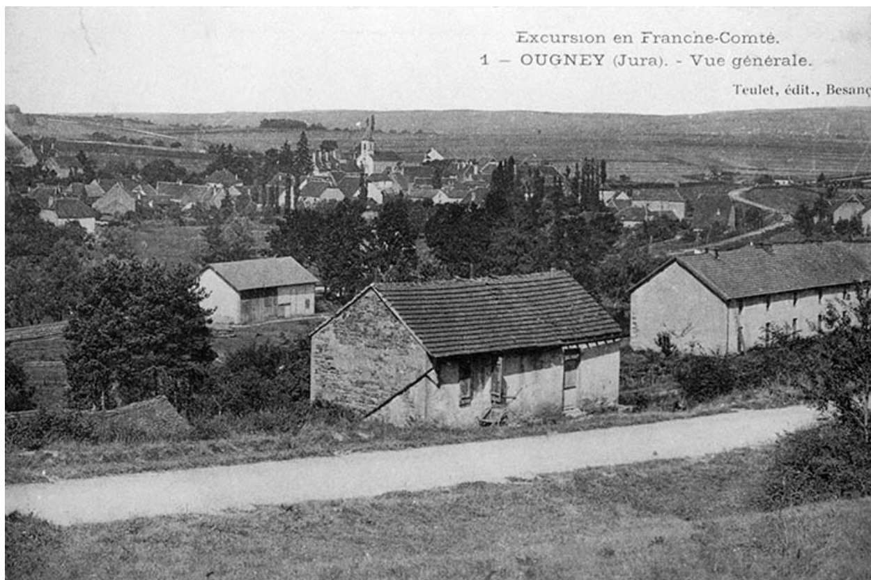
Ougney (Jura). - Vue générale. A droite, la " Caserne ".
