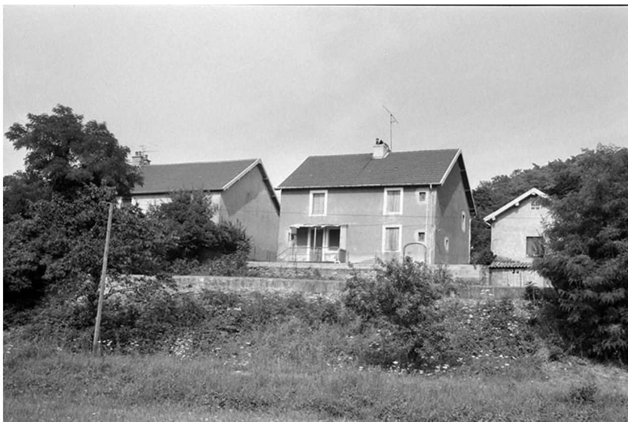
Façade postérieure de la "Caserne" (A, B).
