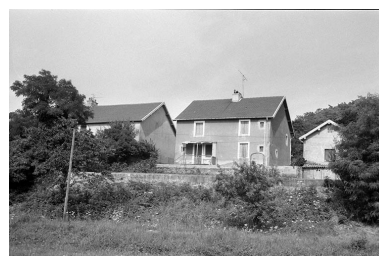
Façade postérieure de la "Caserne" (A, B). Phot. Laurent Poupard
