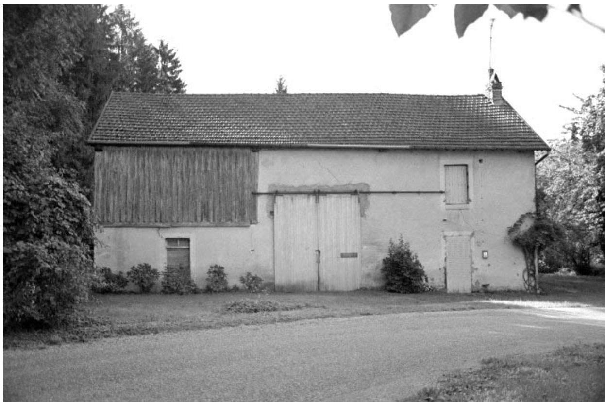
Façade antérieure du logement de contremaître (D).
