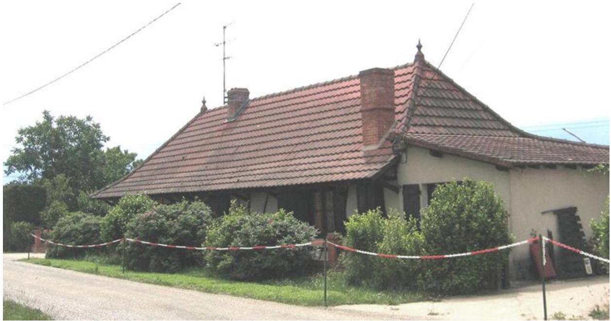
Vue d'ensemble de la façade.
