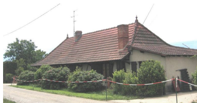
Vue d'ensemble de la façade.
