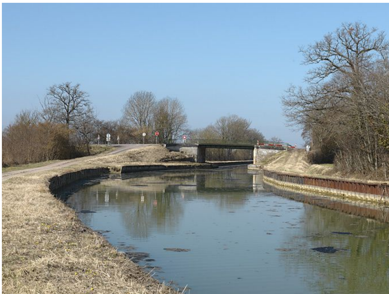
Vue d'ensemble du pont.
