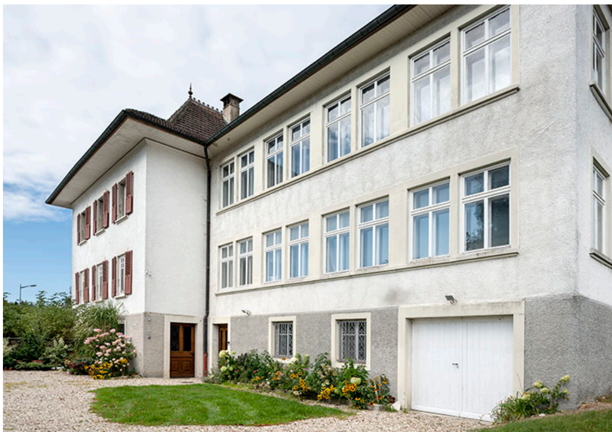
Usine d'échappements à ancre Gaston puis Yvonne Cuenin, à Bonnétable.
