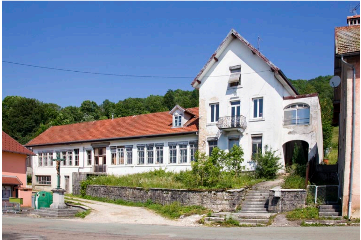
Usine de boîtes de montre Nappey Frères, à Charmauvillers.
