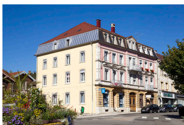
Immeuble et fabrique de montres Les Fils d'Edouard Wetzel puis Montres Thalès, à Morteau. Phot. Yves Sancey IVR43_20132502182NUC2A
