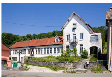
Usine de boîtes de montre Nappey Frères, à Charmauvillers. Phot. Yves Sancey IVR43_20132501224NUC2A
