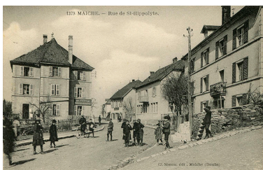
Réutilisation d'un bâtiment existant (1866) à Maïche : la fabrique d'échappements à cylindre Delacour Frères, après la Première Guerre mondiale (et l'ouverture de fenêtres multiples au 1er niveau). Autr. Charles Simon IVR43_20152502038NUC4A
