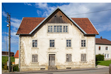
Maison et atelier de montres Pillot puis Fierobe, à Charquemont. Phot. Sonia Dourlot IVR43_20152500852NUC2A
