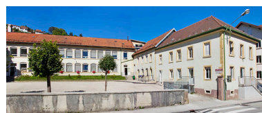
Usine de boîtes de montre Frainier, à Morteau. Phot. Yves Sancey IVR43_20132502104NUC2A
