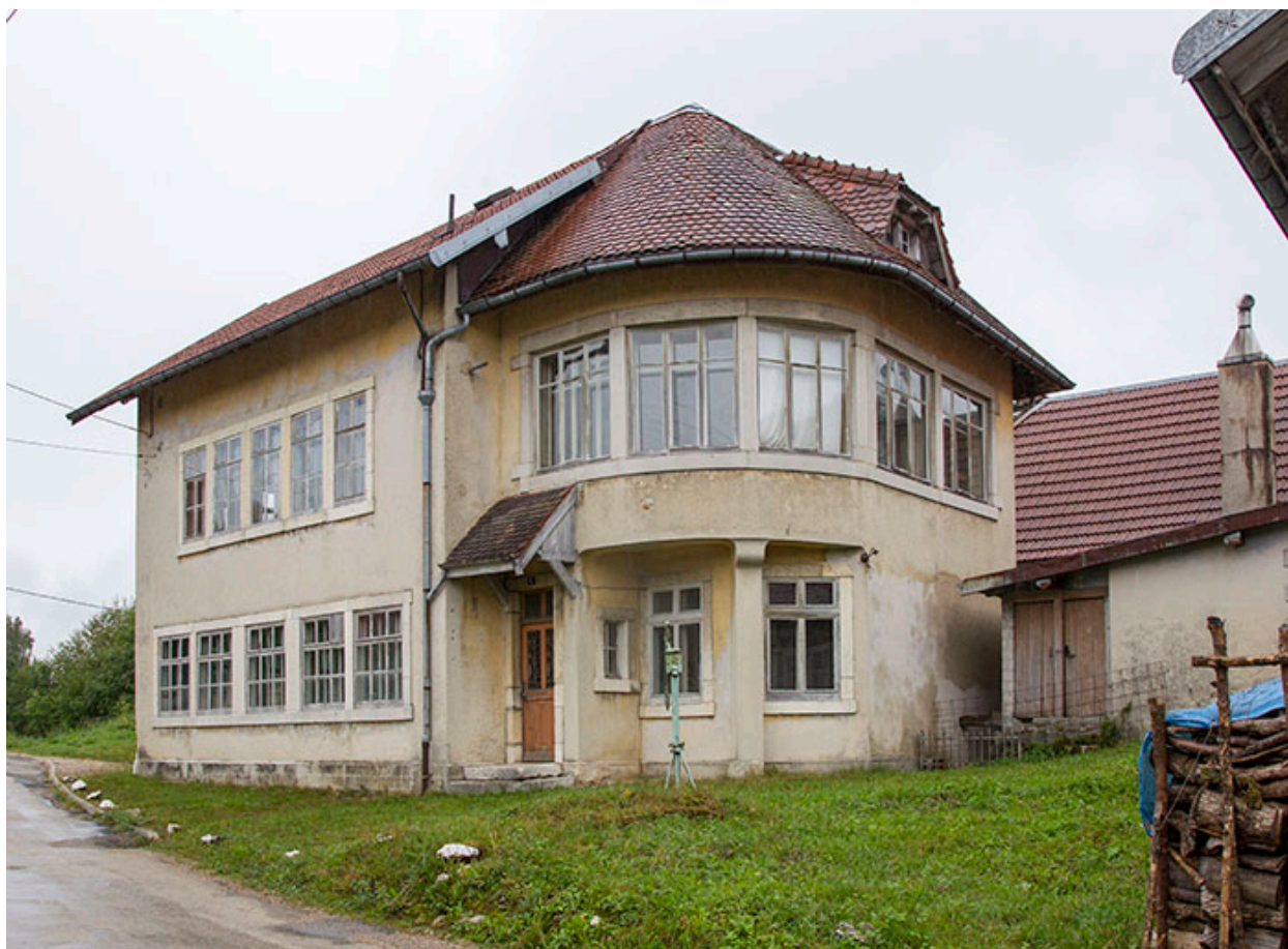
Usine d'échappements à cylindre Aster Frésard, à Charquemont.
