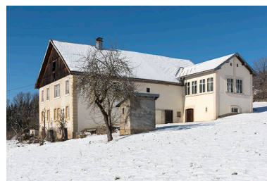
ferme et atelier de balanciers et d'horlogerie Zimmermann, à Villers-le-Lac.
