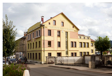
Immeuble et usine de montres et d'instruments de mesure Mercier, à Morteau. Phot. Yves Sancey IVR43_20132502221NUC2A
