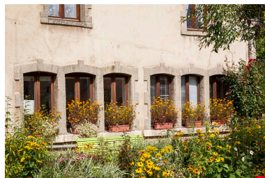
Fenêtres multiples ("fenestration"), à Maîche. Phot. Yves Sancey IVR43_20132501964NUC2A
