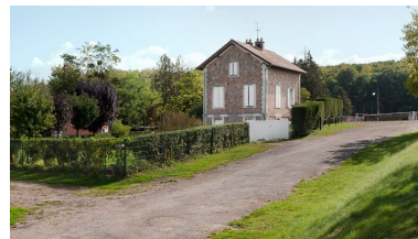
Vue de la maison de garde. Phot. Pierre-Marie Barbe-Richaud IVR26_20112103635NUC4AQ
