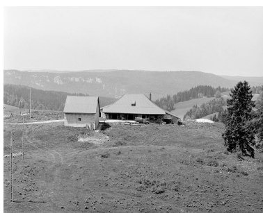
Chalet d'estive situé au lieudit La Pile dessous. Phot. Yves Sancey IVR43_19993900107X
