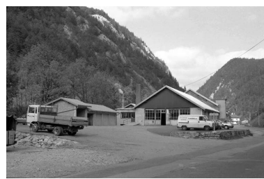
Scierie Ch. Cochet puis Gauthier, actuellement usine de traitement de surface des métaux Henri Morel et Cie - lieudit La Cassine. Phot. Laurent Poupard IVR43_19903900645Z
