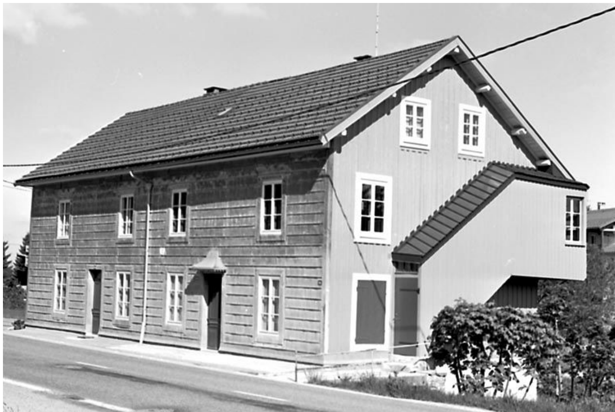
Maison-atelier située route du Noirmont.
