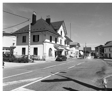
La douane située au lieudit La Cure. Phot. Jérôme Mongreville IVR43_20013900421X
