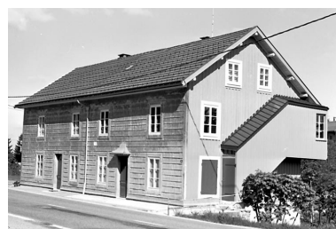
Maison-atelier située route du Noirmont. Phot. Jérôme Mongreville IVR43_20013900490X
