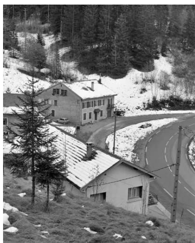
Auberge, relais de poste, atelier d'horlogerie puis de traitement de surface des métaux - lieudit Sous les Barres.
