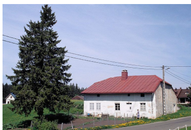
Ferme située route Royale. Phot. Yves Sancey IVR43_19993900081ZA
