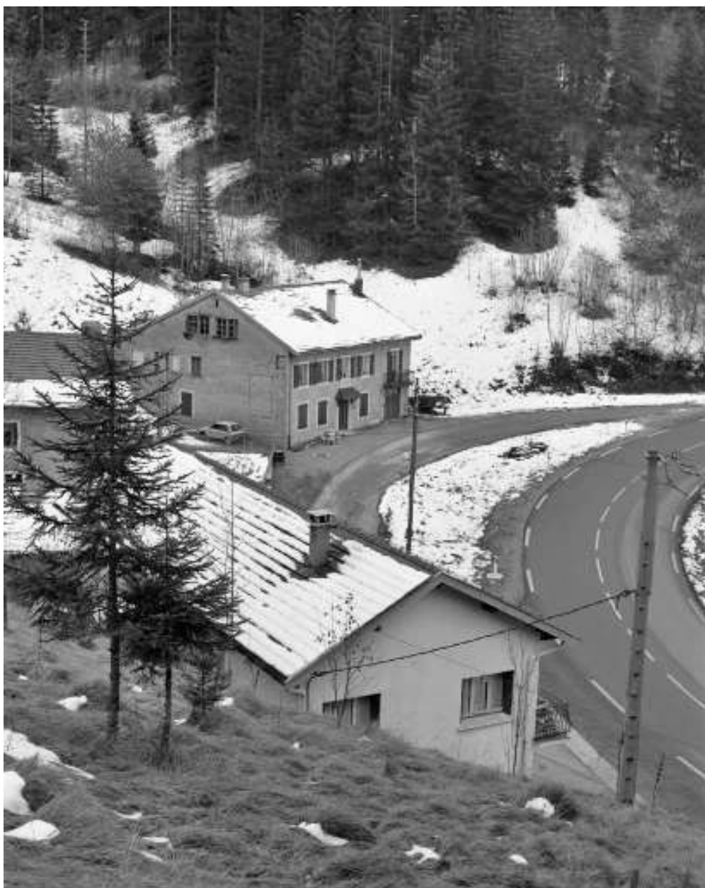
Auberge, relais de poste, atelier d'horlogerie puis de traitement de surface des métaux - lieudit Sous les Barres.
