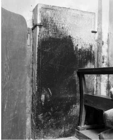
Vue générale. Phot. Michel Thierry IVR26_19852101427X
