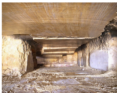
Intérieur, partie centrale, depuis une entrée. Au fond à droite, poulies de renvoi du fil hélicoïdal. Phot. Yves Sancey IVR43_19973900150XA
