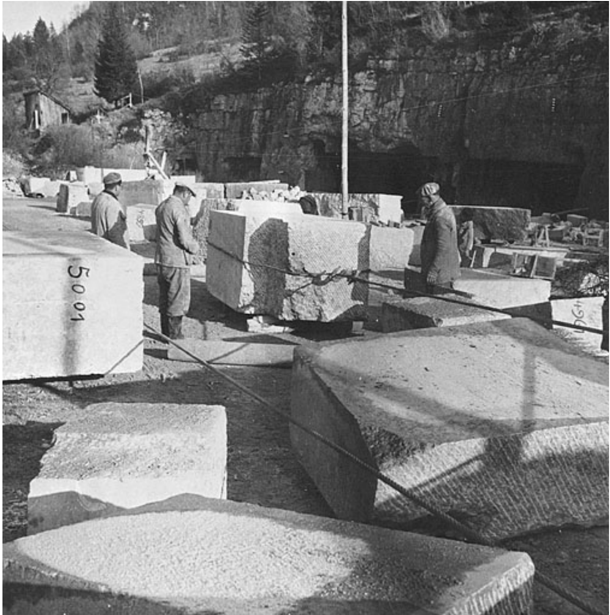
Tirage d'un bloc sur le chantier.
