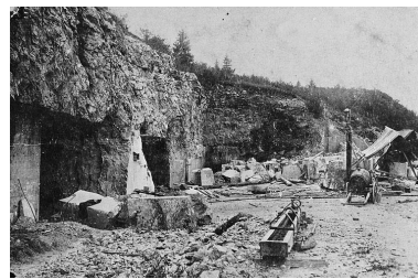
Chantier et entrées de la carrière souterraine.
