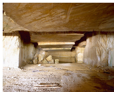
Intérieur, partie sud-ouest. Phot. Yves Sancey IVR43_19973900144XA
