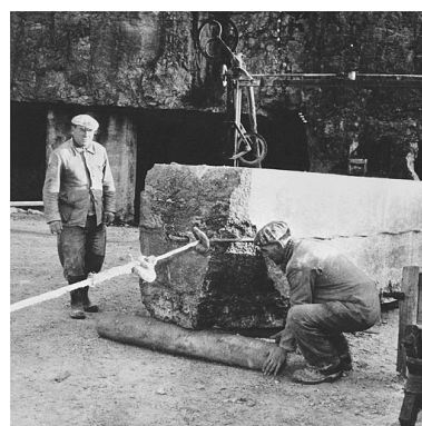
Tirage d'un bloc sur le chantier : mise en place de rouleaux sous le bloc.
