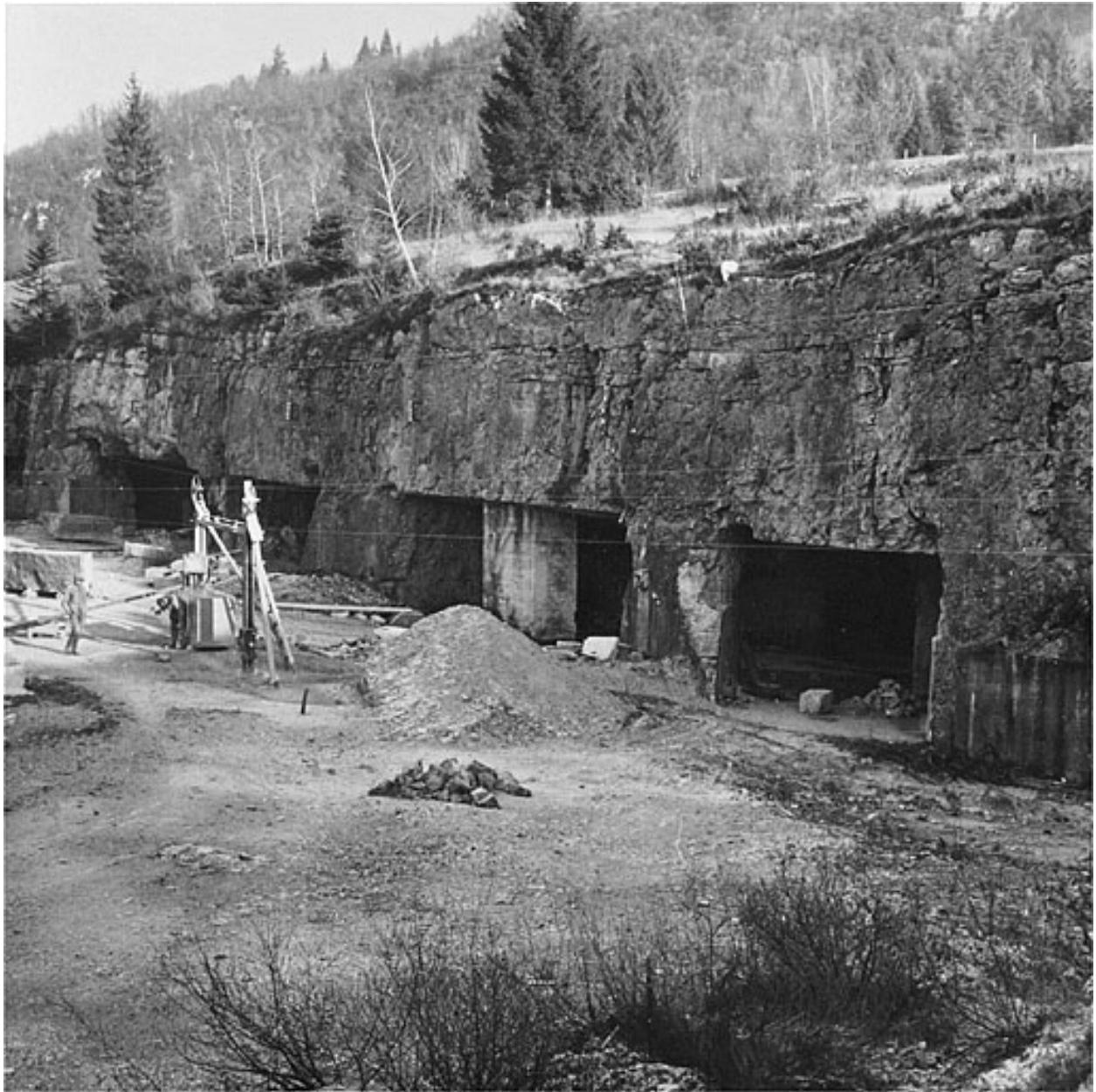
Chantier et entrées de la carrière souterraine.
