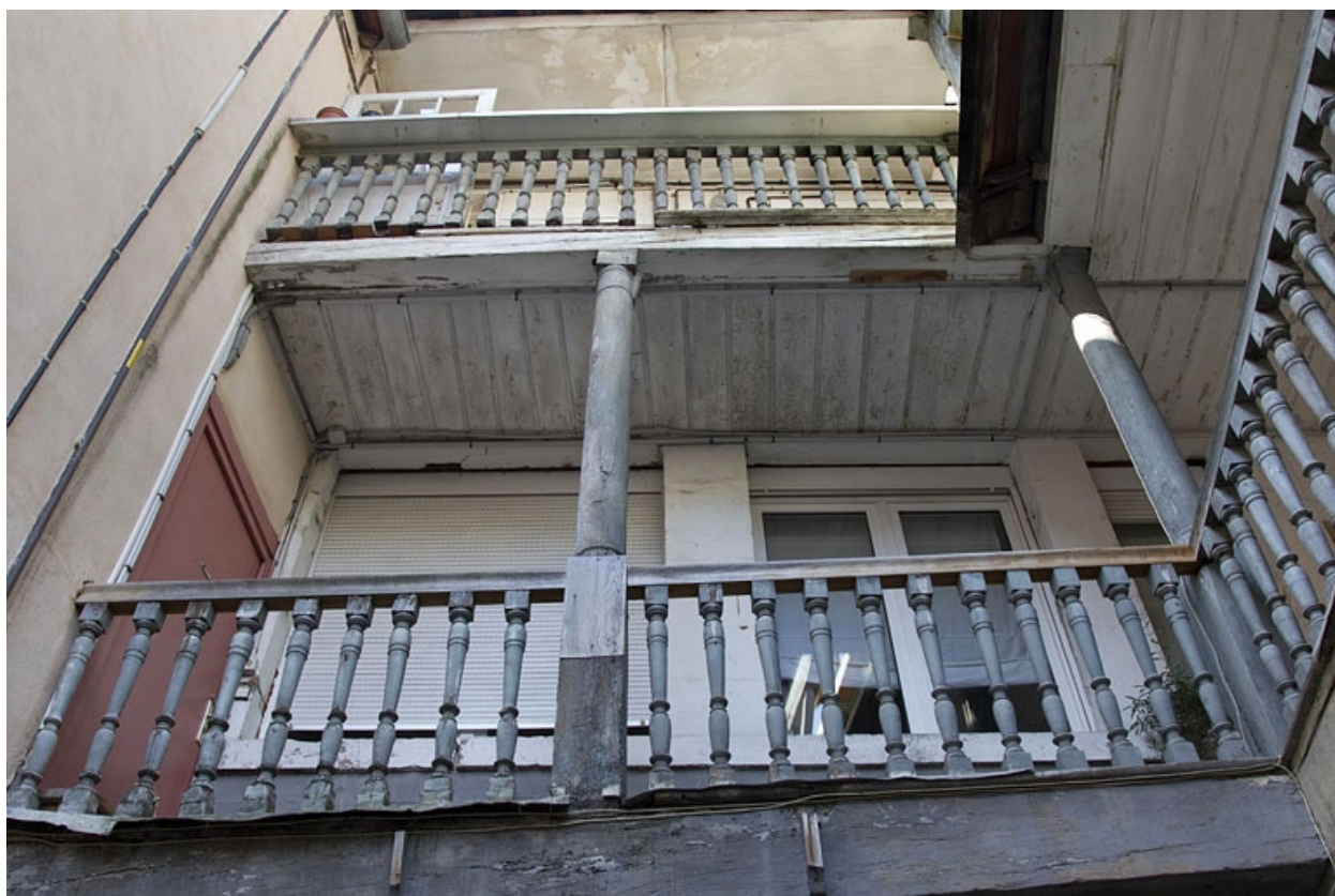
Escalier extérieur : détail des coursières, de face.
