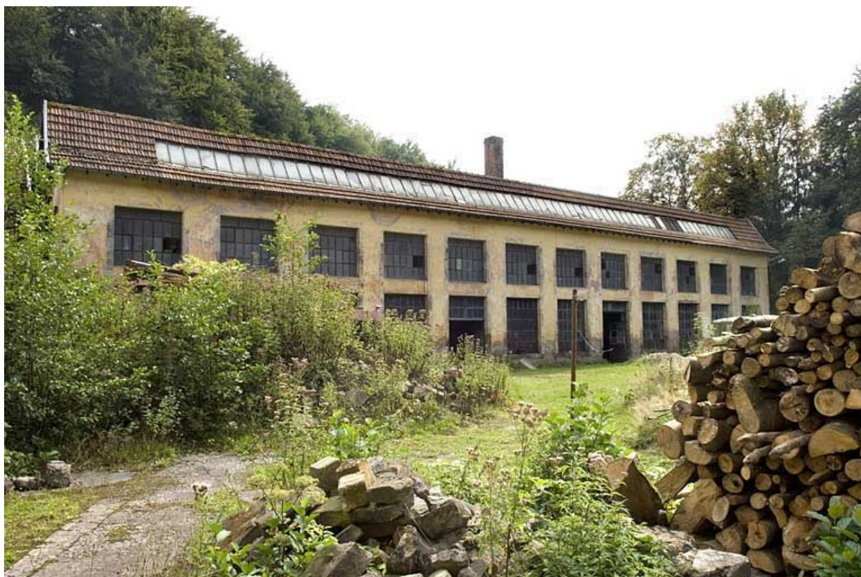
Façade occidentale de l'atelier de fabrication.
