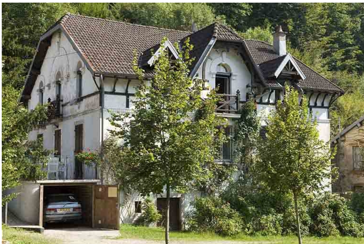
Logement du directeur. Façade postérieure.
