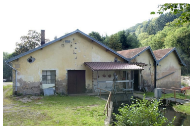
Pignon nord de l'atelier de fabrication. Phot. Jérôme Mongreville IVR43_20067000727NUCA
