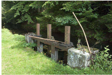
Vanne de décharge sur le bief d'amenée. Phot. Jérôme Mongreville IVR43_20067000726NUCA
