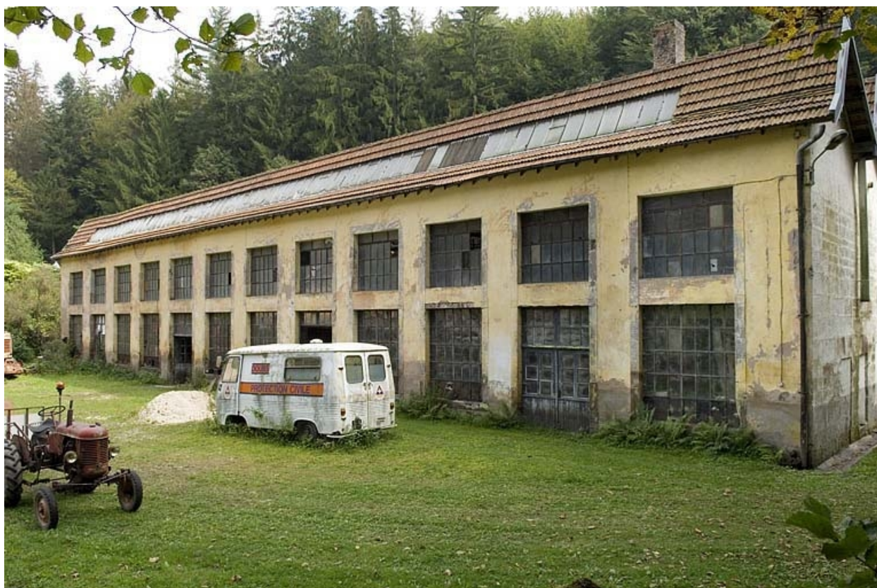
Elévation ouest de l'atelier de fabrication.
