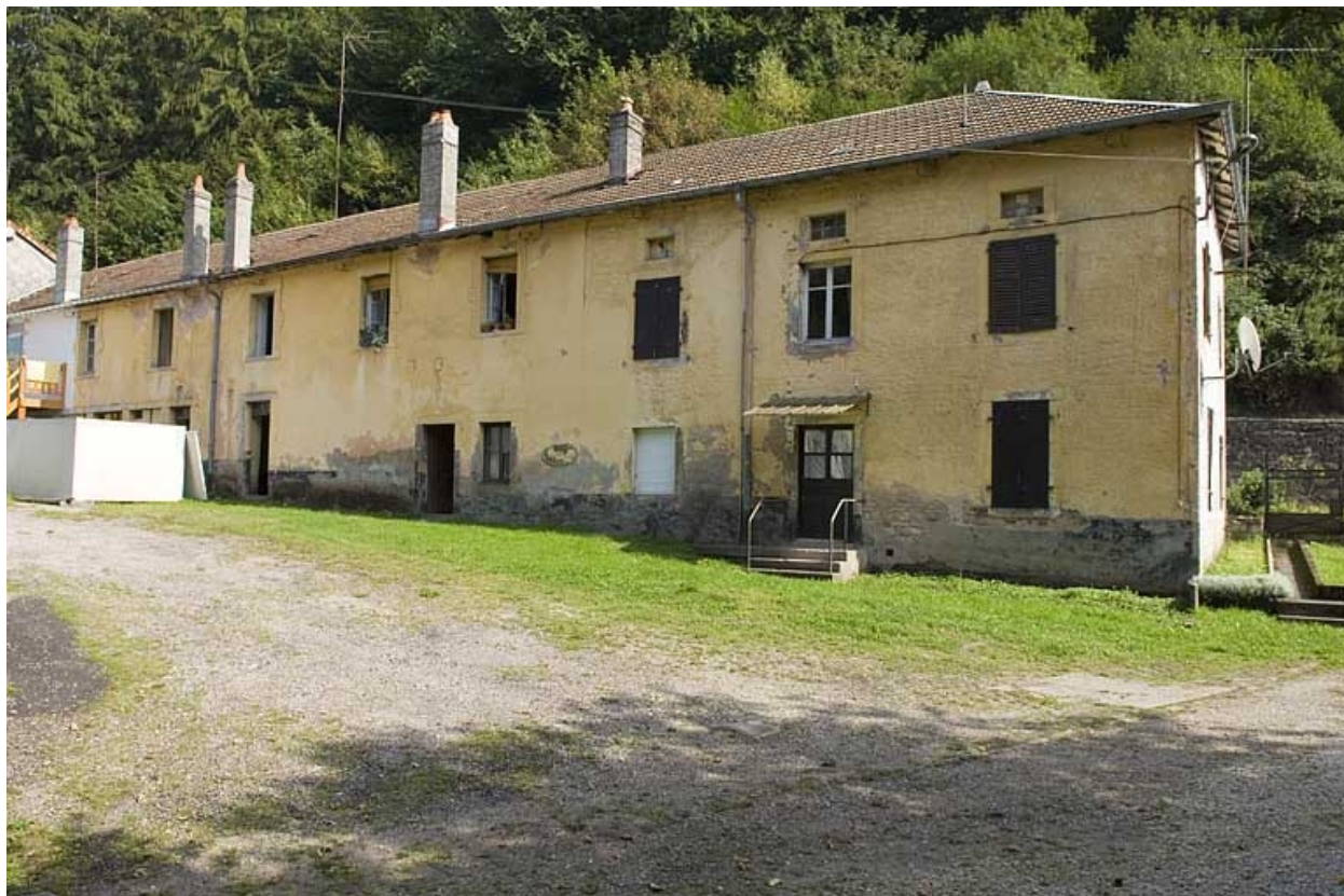
Façade occidentale des logements ouvriers.
