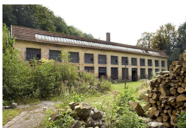
Façade occidentale de l'atelier de fabrication. Phot. Jérôme Mongreville IVR43_20067000722NUCA
