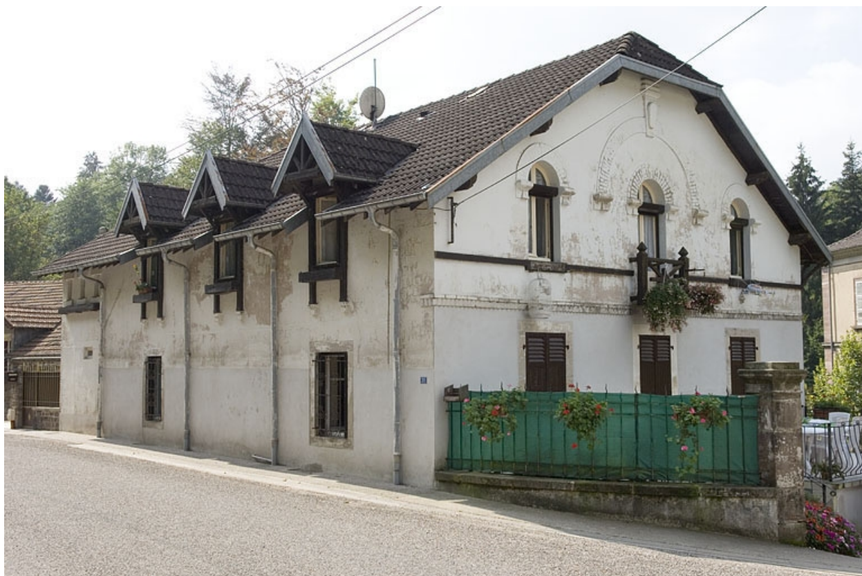
Logement du directeur. Vue depuis la route.
