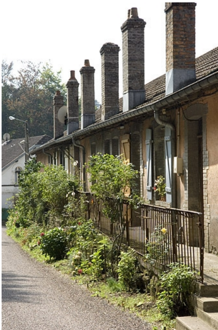
Façade des logements ouvriers route de Plombières.
