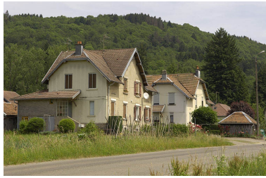
Vue d'ensemble des logements de contremaître. Phot. Jérôme Mongreville IVR43_20057000331NUCA
