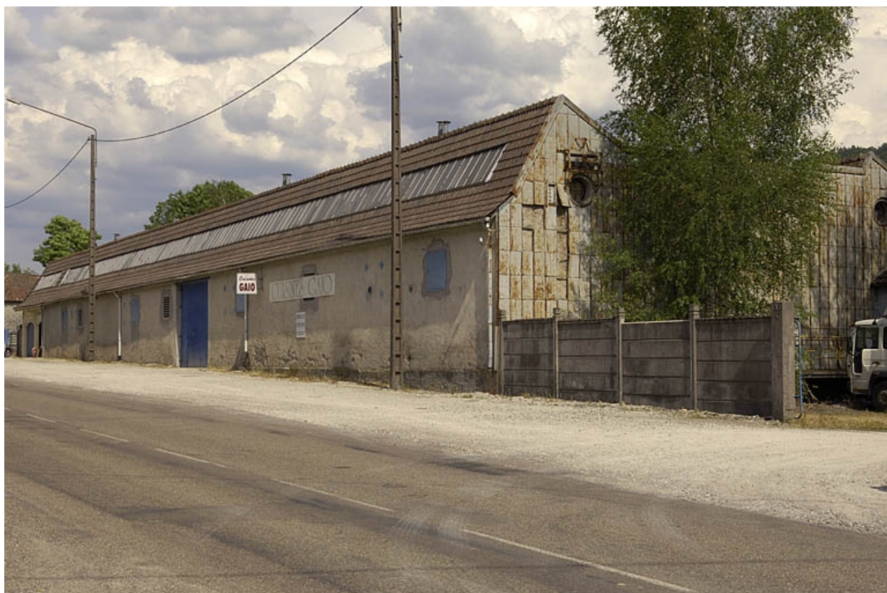
Travées nord de l'atelier de fabrication (tissage).
