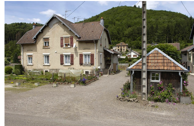
Logement de contremaître. Phot. Jérôme Mongreville IVR43_20057000319NUCA
