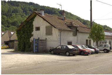
La conciergerie et l'atelier de filature. Phot. Jérôme Mongreville IVR43_20057000333NUCA
