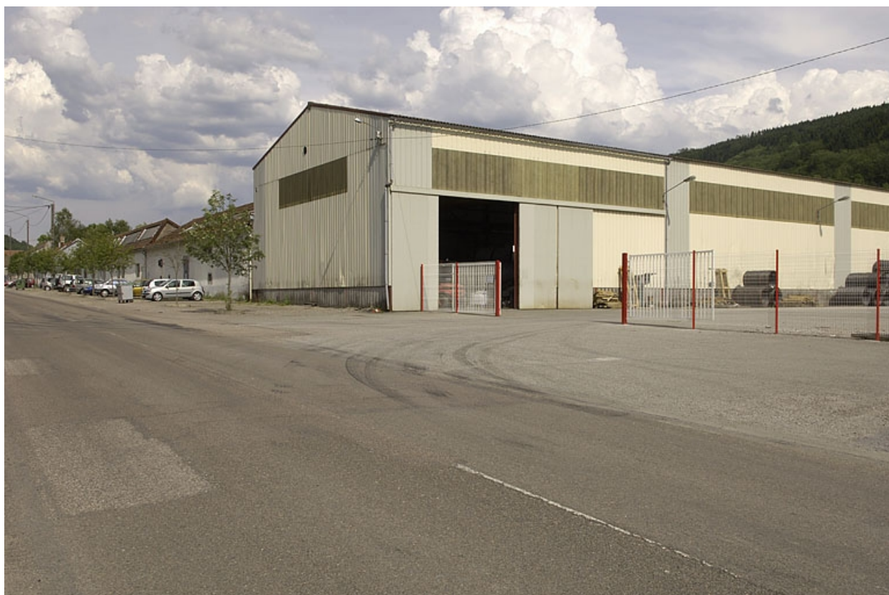
Atelier de fabrication (filature) et extension ouest.
