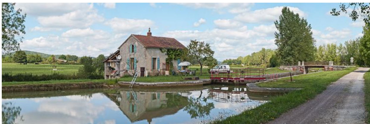
Vue d'ensemble du site d'écluse.
