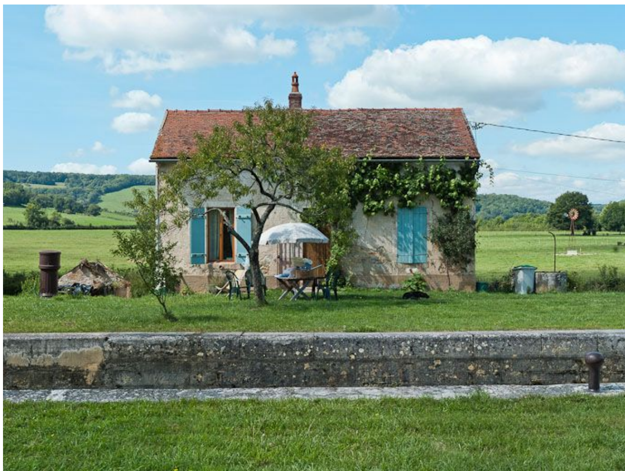
Vue de face de la maison éclusière.
