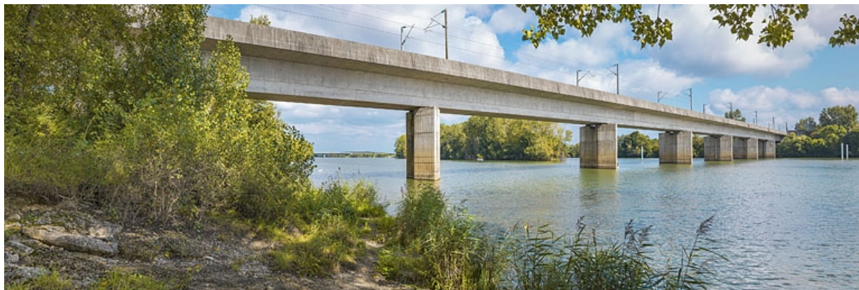
Vue d'ensemble du pont, d'aval et depuis la rive droite.
