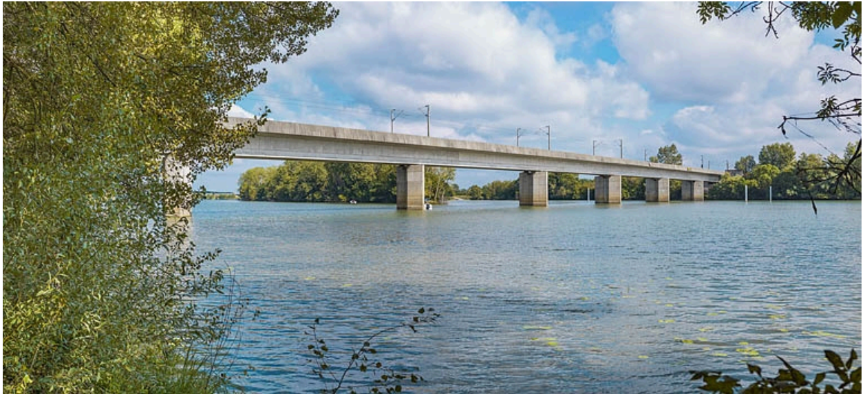
Vue d'ensemble du pont, d'aval et depuis la rive droite.
