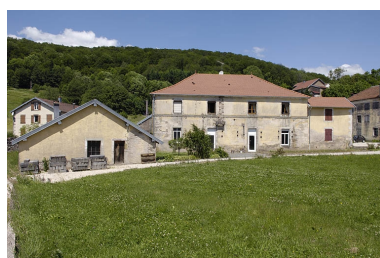
Ancienne menuiserie et forge de la filature. Phot. Jérôme Mongreville IVR43_20057000377NUCA
