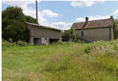
Vue du jardin et des annexes du site d'écluse. Phot. Pierre-Marie Barbe-Richaud IVR26_20118900305NUC4AQ
