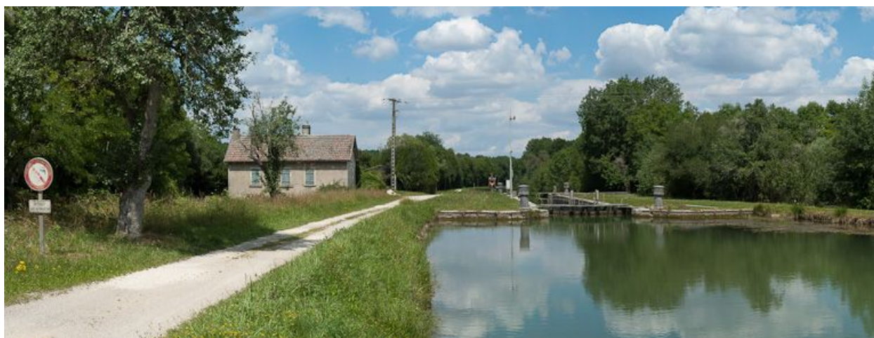
Vue du site d'écluse depuis l'amont.
