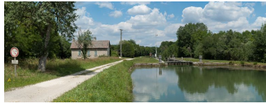
Vue du site d'écluse depuis l'amont. Phot. Pierre-Marie Barbe-Richaud IVR26_20118900297NUC4AQ
