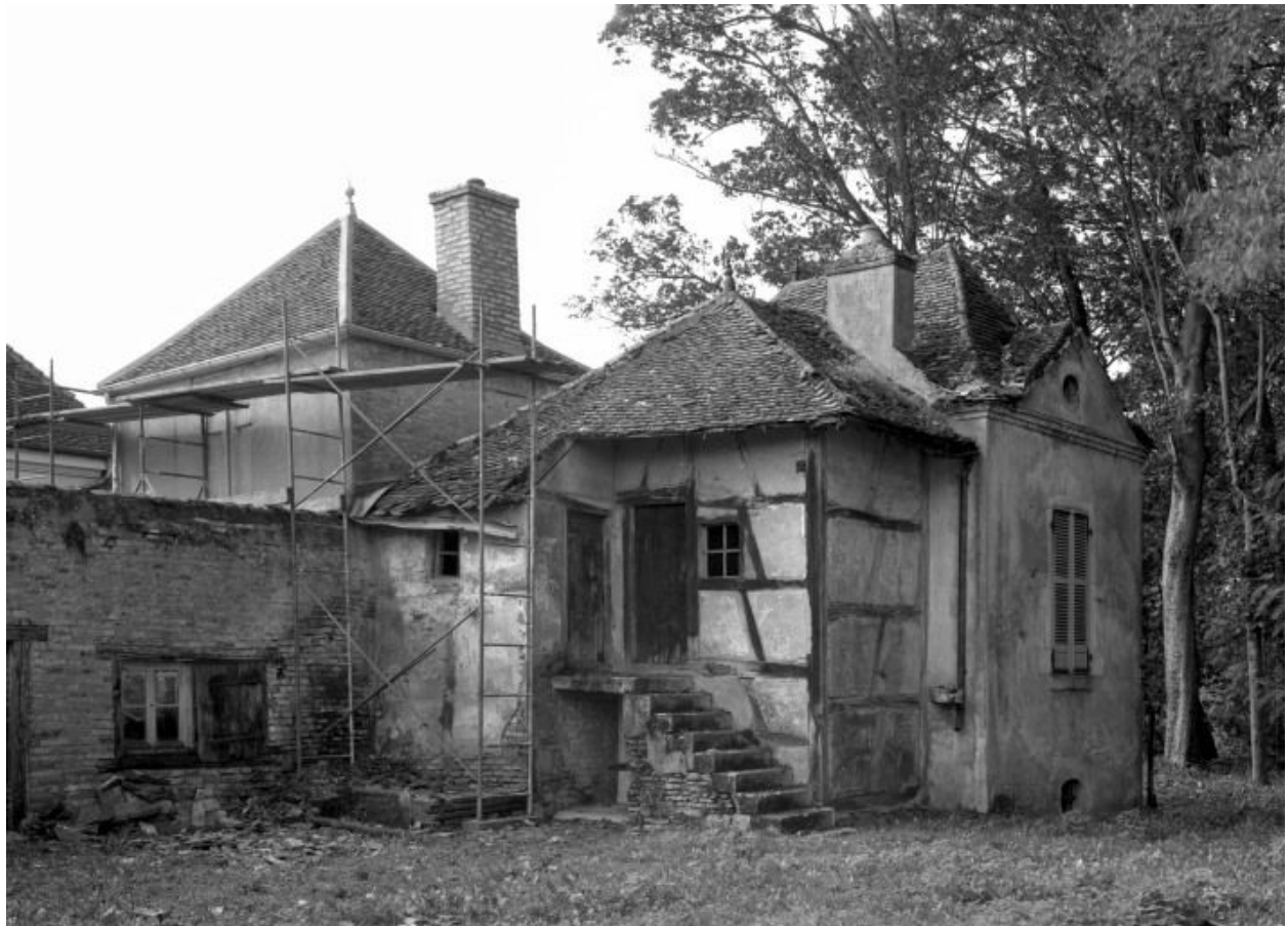
Souillarde" et pavillon.
