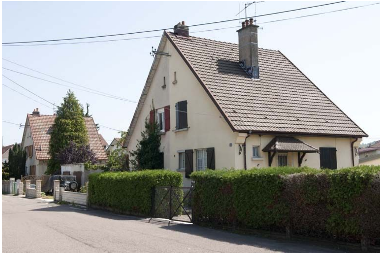
Maisons jumelées rue de Bourgogne.
