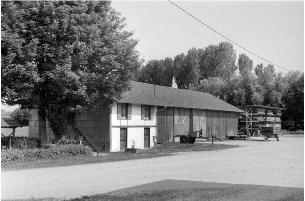
Magasin industriel (M) et logement d'ouvriers (N).
