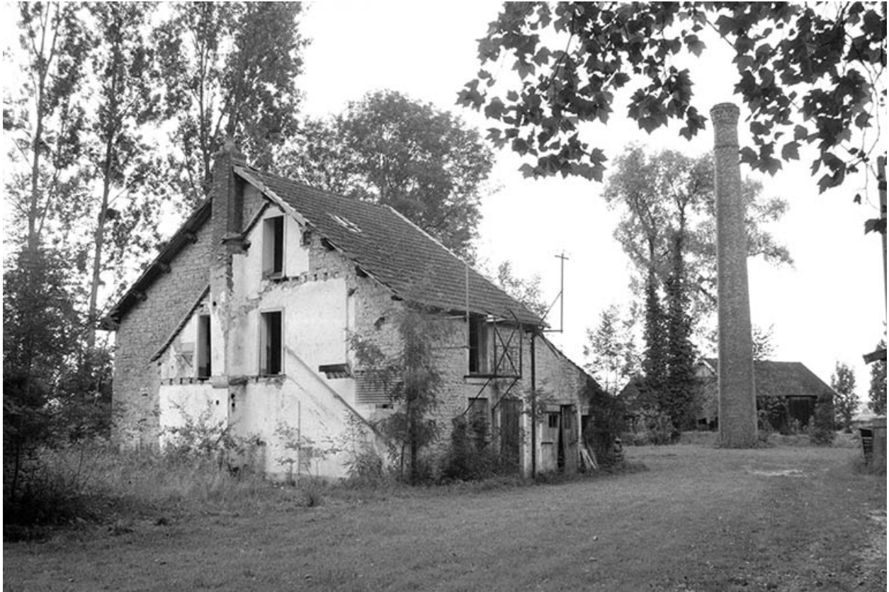
Ecuries (G) et cheminée d'usine (F).
