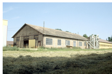
Atelier de fabrication (K), depuis le sud.
