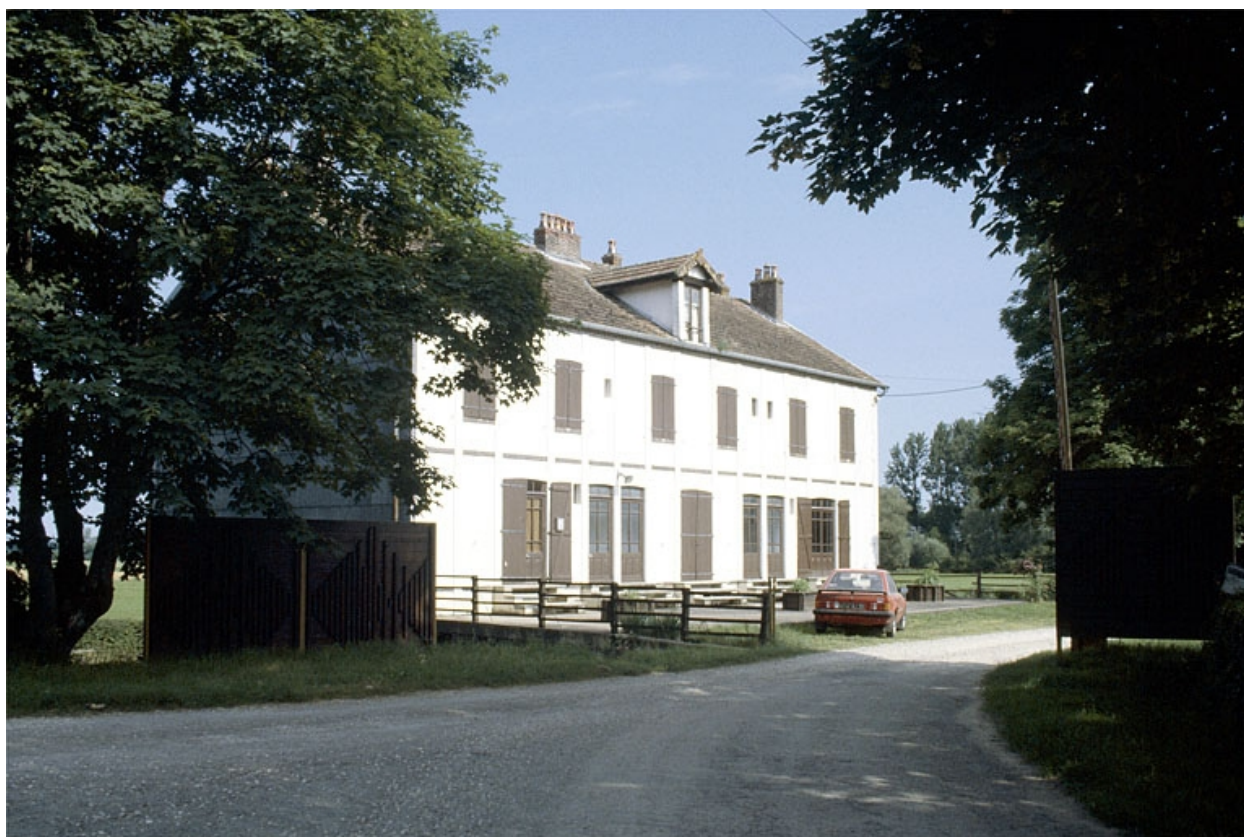
Logement d'ouvriers (O), depuis l'entrée de l'usine.
