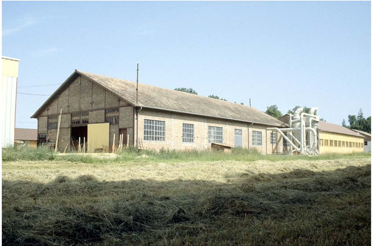
Atelier de fabrication (K), depuis le sud.
