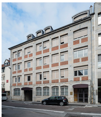
Usine d'horlogerie (23 rue Gambetta). Phot. Jérôme Mongreville IVR43_20172501345NUC4A
