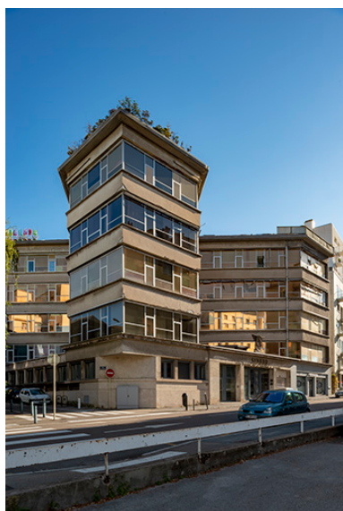
Immeuble industriel de la Sidhor (23 rue de la Mouillère). Phot. Jérôme Mongreville IVR43_20192500107NUC4A
