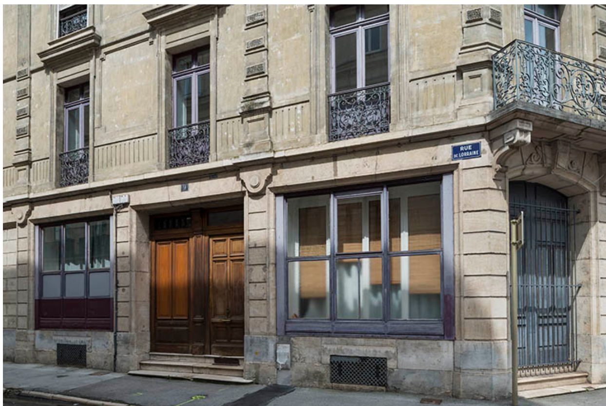
immeuble et atelier d'horlogerie Bossy (9 rue de Lorraine).
