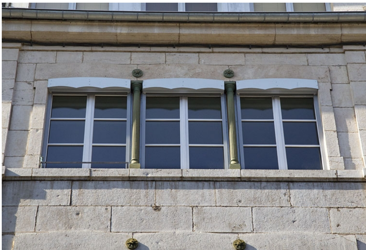
Immeuble 1 rue Prodouhon. Détail d'une baie horlogère (1er étage).
