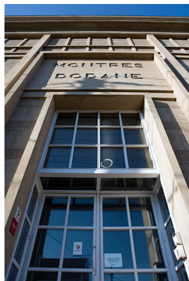
Usine d'horlogerie Dodane. Entrée vue en contre-plongée (5-7 avenue de Montrapon). Phot. Yves Sancey IVR43_20062500589NUCA
