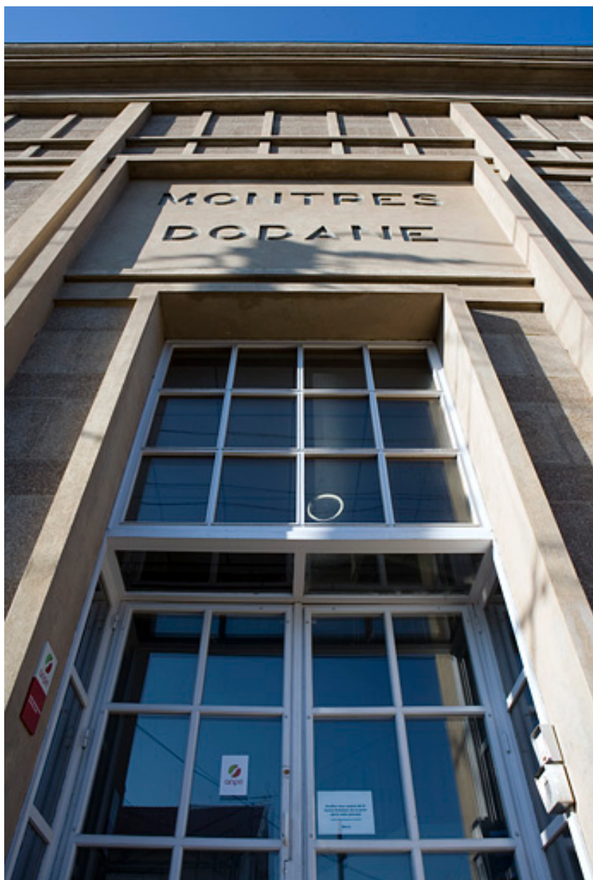
Usine d'horlogerie Dodane. Entrée vue en contre-plongée (5-7 avenue de Montrapon).
